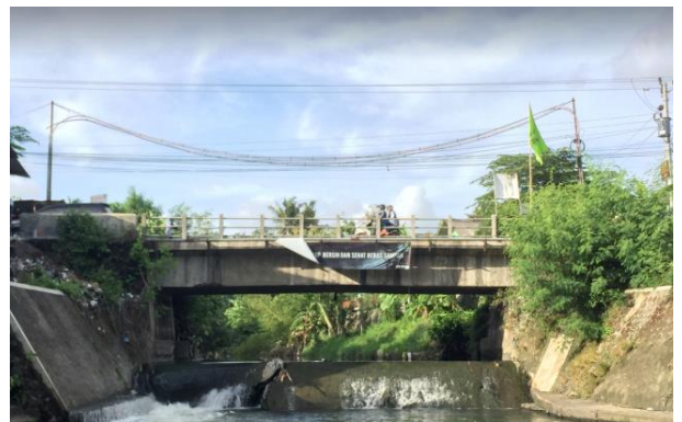
Gambar 7 Foto Jembatan Beton.
