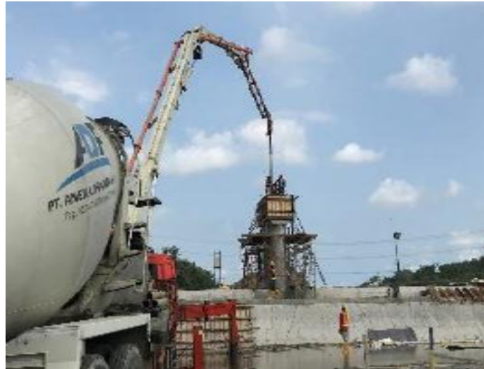
Gambar 4.11 Pengecoran tiang mercu
