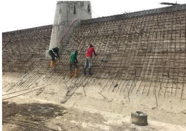
Gambar 4.5 Penulangan tubuh bendung
