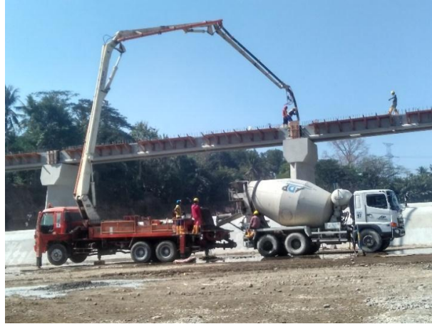
Gambar 4.20 Proses pengecoran lantai jembatan
