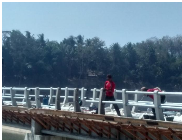
Gambar 4.19 Pemasangan pipa
