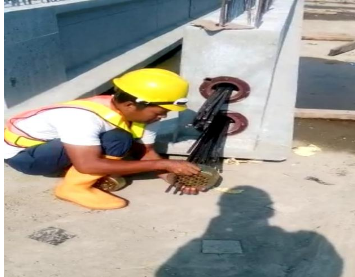
Gambar 4.14 Proses pelaksanaan stressing pada girder
