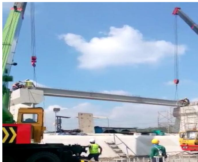
Gambar 4.13 Proses pemasangan girder
