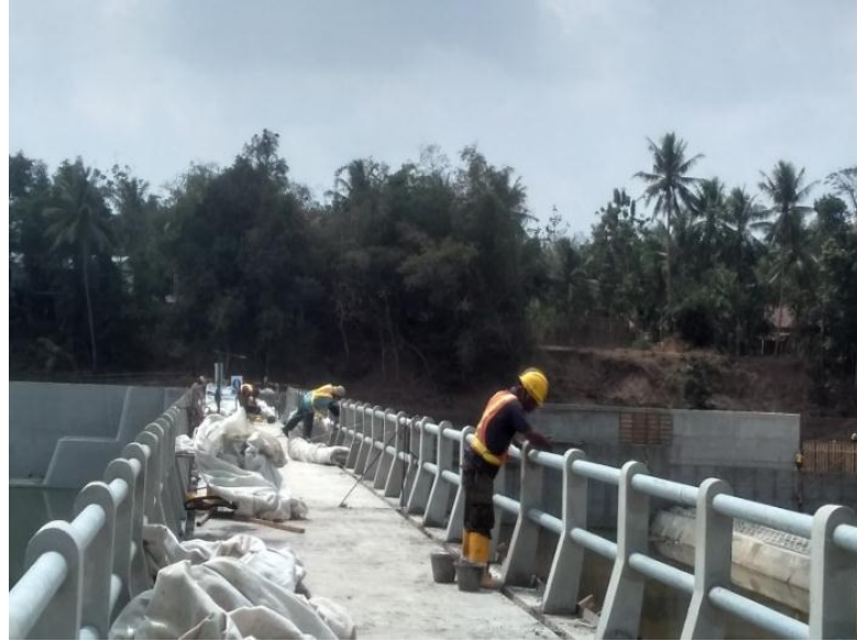
Gambar 4.22 Pengecatan tiang ralling
