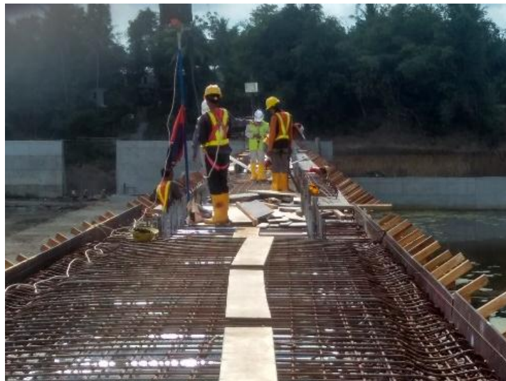
Gambar 4.17 Pekerjaan penulangan lantai jembatan
