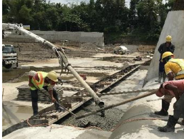
Gambar 4.7 Pengecoran tubuh bendung
