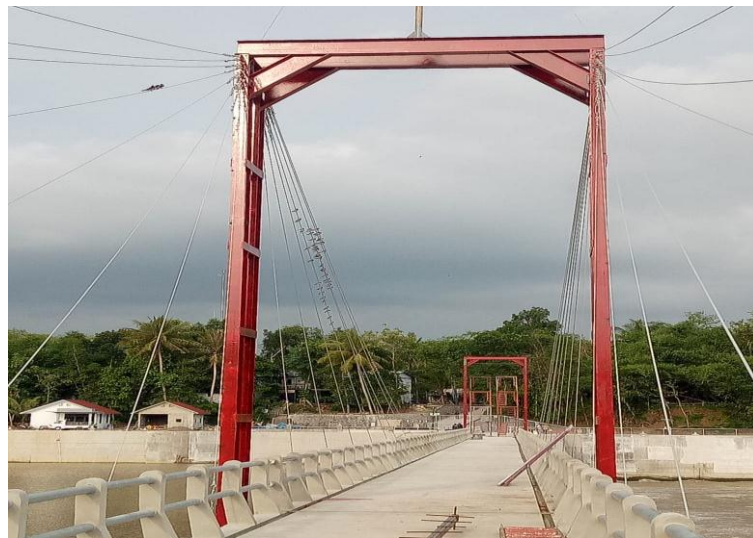
Gambar 4.23 Pemasangan tiang WF
