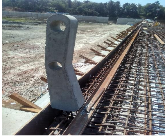
Gambar 4.18 Pemasangan tiang ralling
