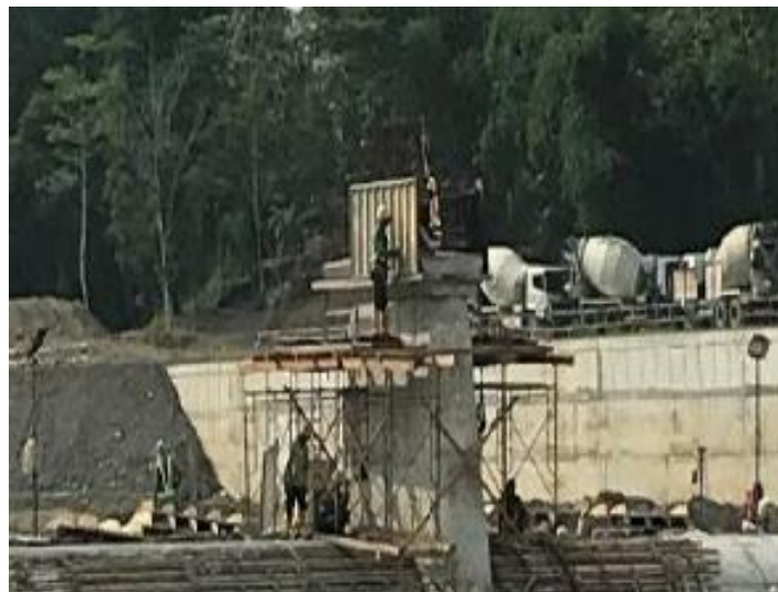
Gambar 4.10 Pemasangan bekisting
