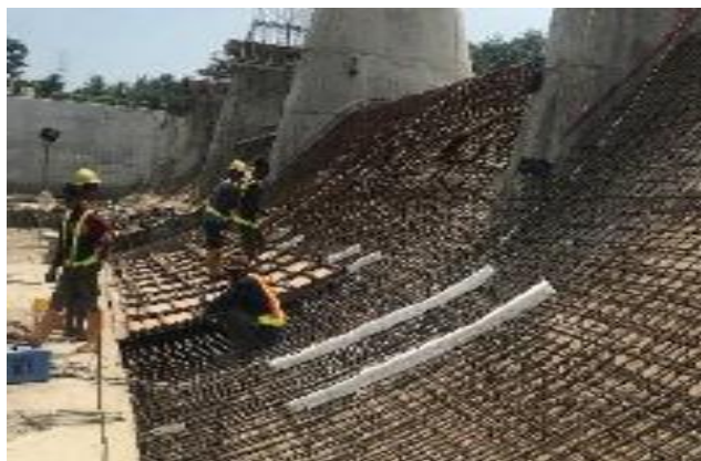
Gambar 4.6 Pemasangan bekisting tubuh bendung
