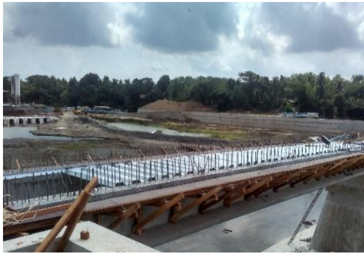
Gambar 4.16 Pemasangan smartdeck
