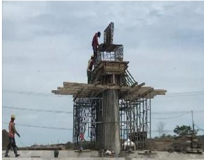
Gambar 4.9 Penulangan tiang mercu
