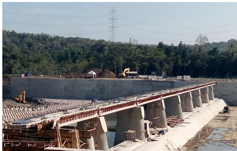
Gambar 3.2 Jembatan tampak samping kiri
