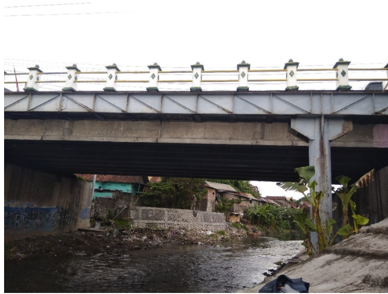
Gambar 4.25 Foto jembatan beton
