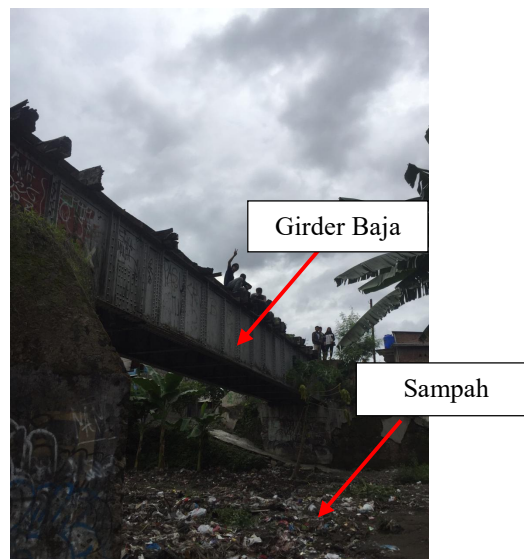
Gambar 4.19 Foto girder baja
