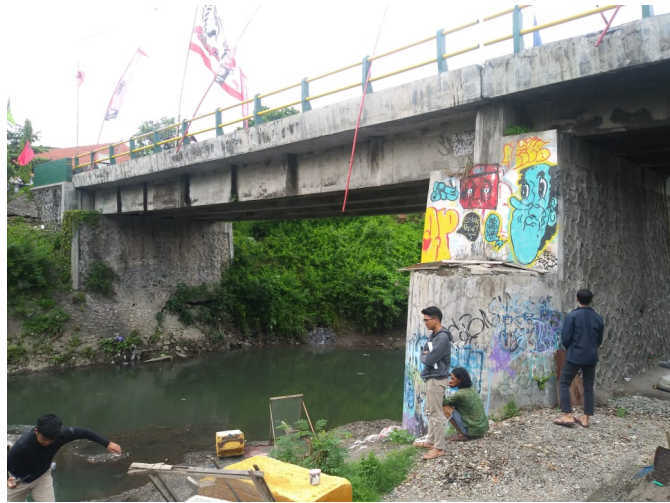
Gambar 4.21 Foto jembatan beton
