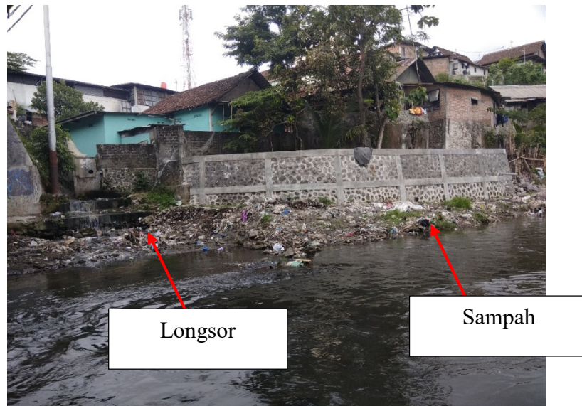
Gambar 4.26 Pemukiman warga disekitar jembatan
