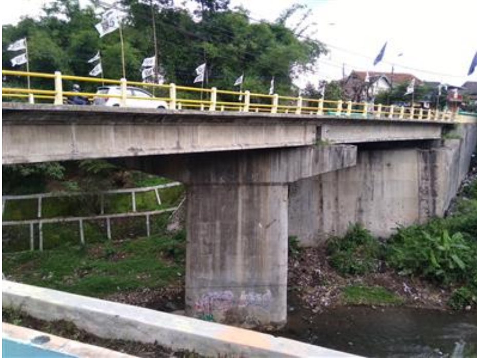
Gambar 4.23 Jembatan beton dengan satu pilar di badan sungai
