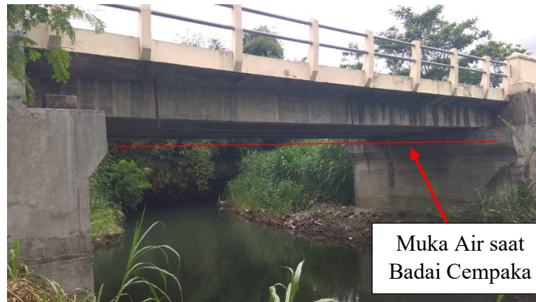
Gambar 4.30 Foto jembatan beton
