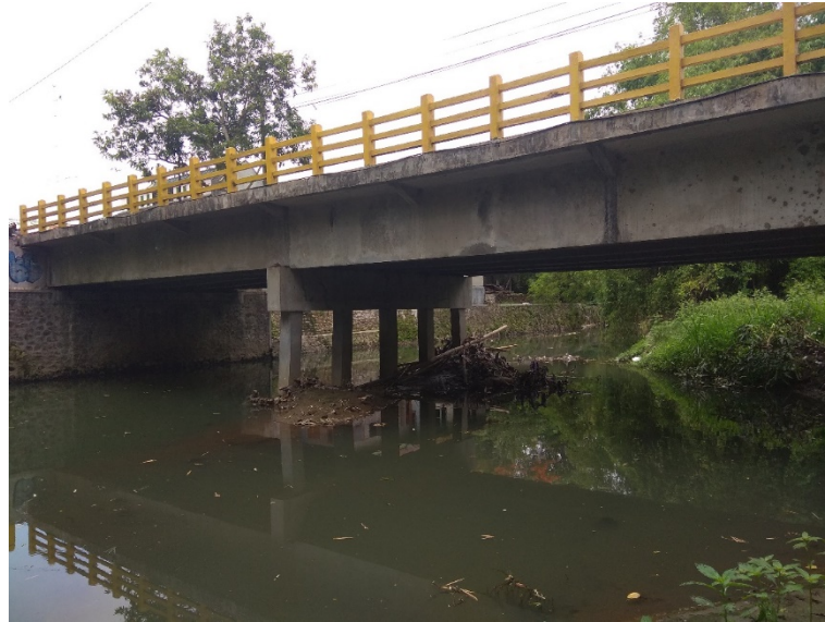
Gambar 4.28 Foto jembatan beton
