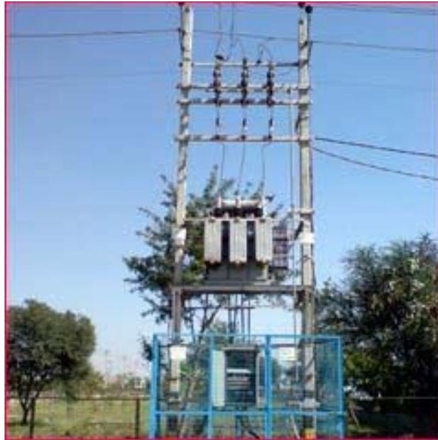
**Gambar 2.2.1** Gardu Listrik Tegangan Menengah
