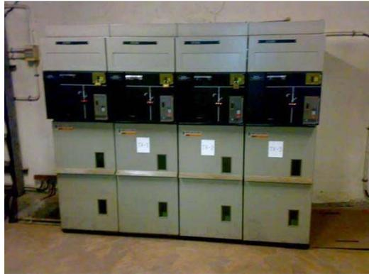
**Gambar 2.2.2** Panel Listrik Tegangan Menengah
