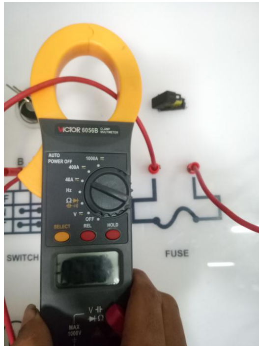
Gambar 4.28 Pengukuran Arus Yang Keluar Dari Fuse
