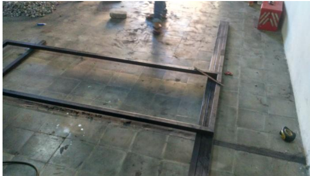
Gambar 3.1 Persiapan material yang digunakan
