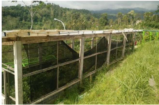
Gambar 9. Green house di Embung Banjaroya
