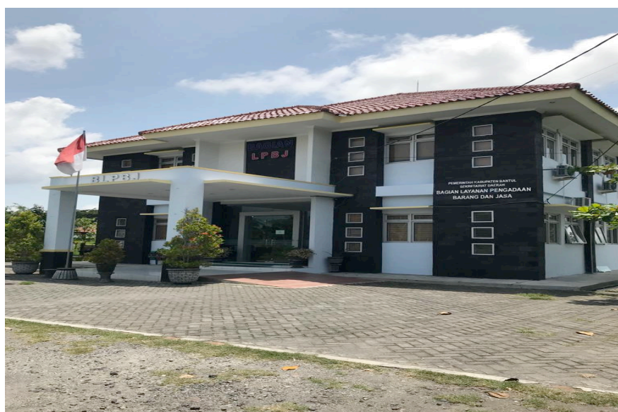
Gambar 2.4 Kantor UKPBJ Kabupaten Bantul
