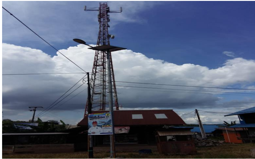
Gambar 5.1. Tower Jaringan Telepon Seluler Di Desa Swarga Bara
