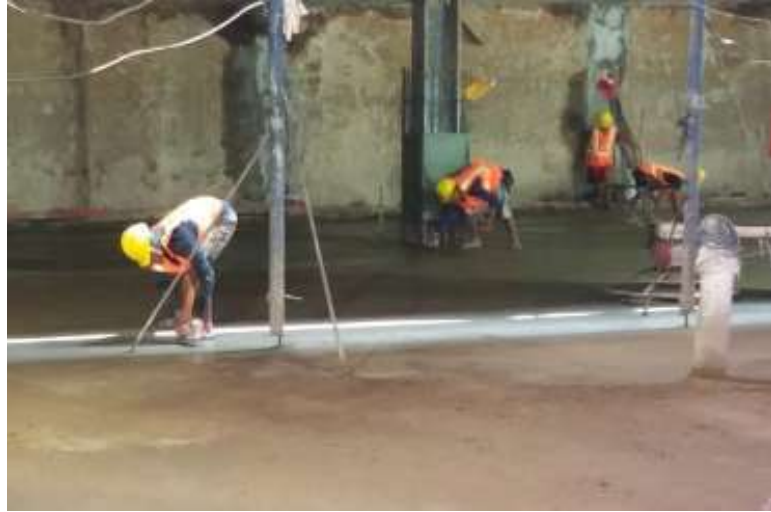
Gambar 2. 9 Pelaksanaan pengecoran mat foundation di lapangan
