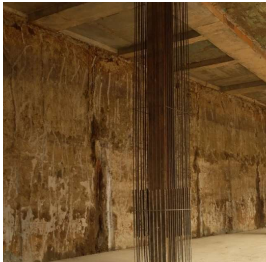
Gambar 2. 5 Dinding diafragma pada basement
