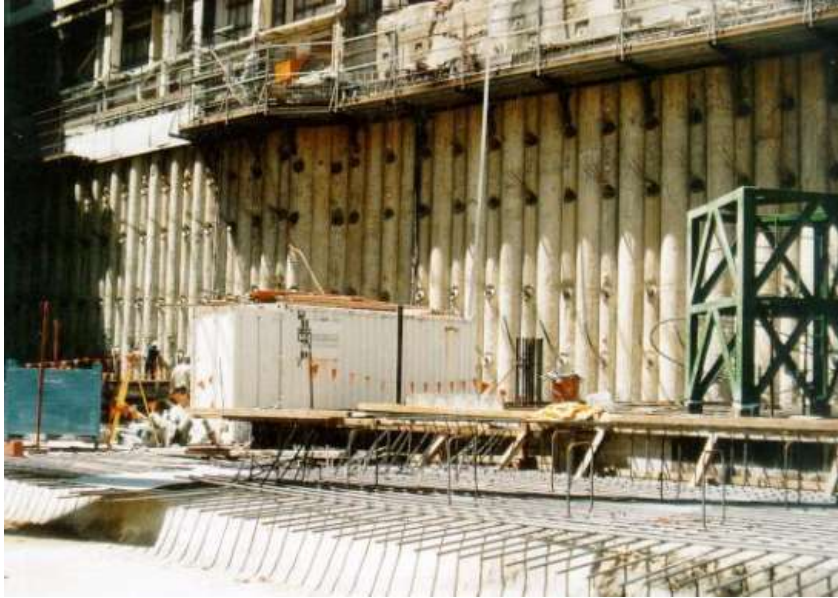
Gambar 2. 7 Penerapan soldier pile di lapangan
