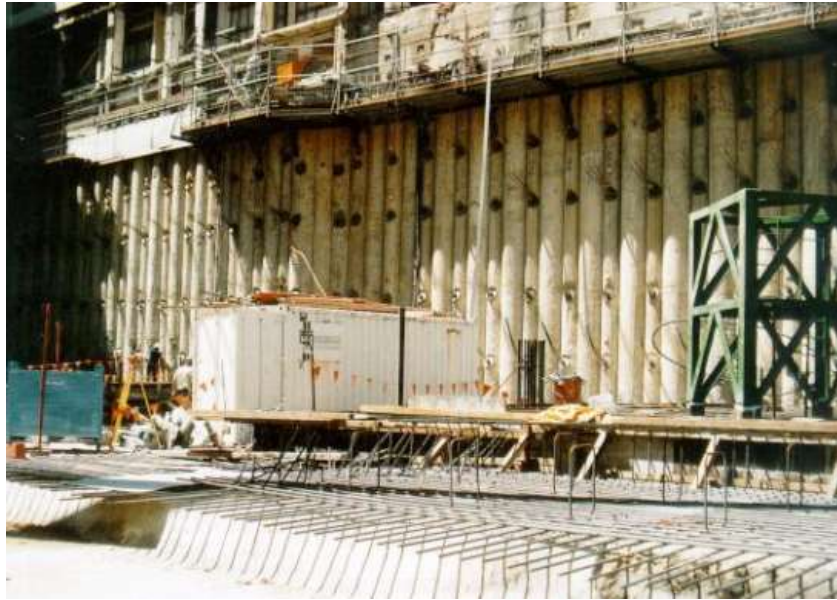
Gambar 2. 7 Penerapan soldier pile di lapangan
