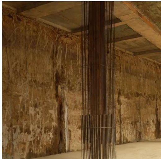
Gambar 2. 5 Dinding diafragma pada basement
