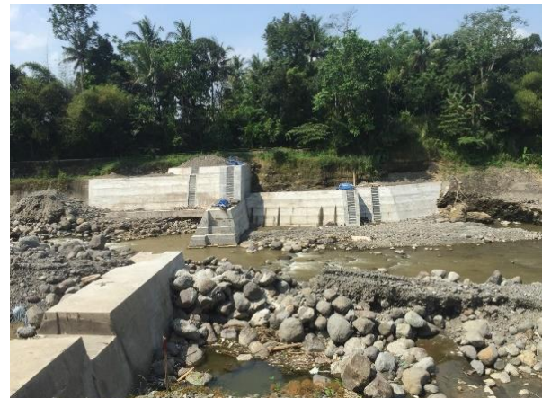
Gambar 8. Pembangunan bendung baru
