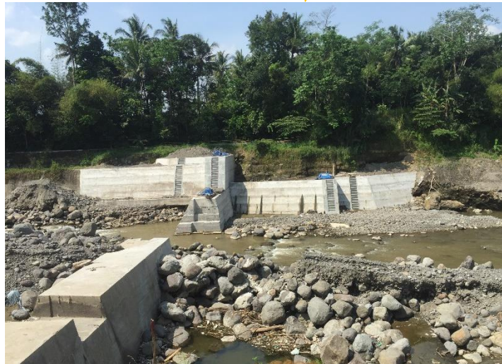
Pembangunan Bendung Baru
