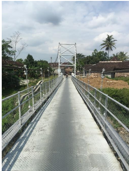
JB01 Jembatan Baja
