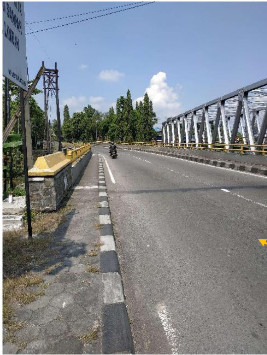
JB08 Jembatan Beton
