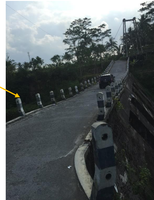
JB03 Jembatan Beton
