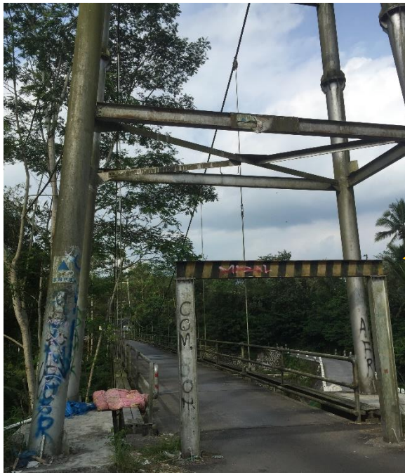
JB02 Jembatan Baja
