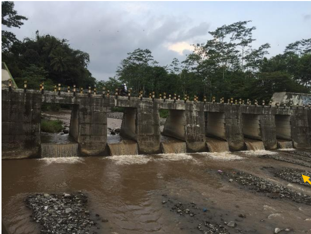
JB06 Jembatan Beton dan check Dam
