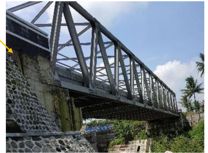
JB09 Jembatan Baja
