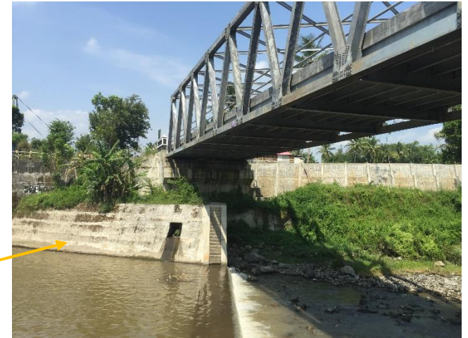
JB05 Jembatan Baja
