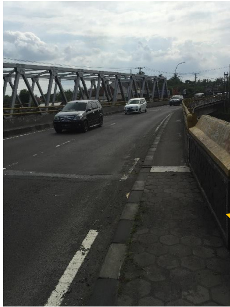
JB04 Jembatan Beton
