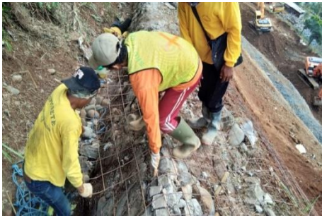
Gambar 10. Proses pemasangan besi wiremesh .
