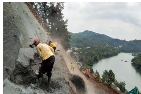
Gambar 14. Proses pembuangan sisa material shotcrete .
