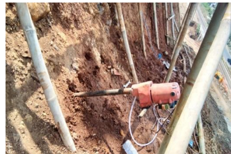
Gambar 7. Proses pengerjaan pondasi ( soil nailing ).
