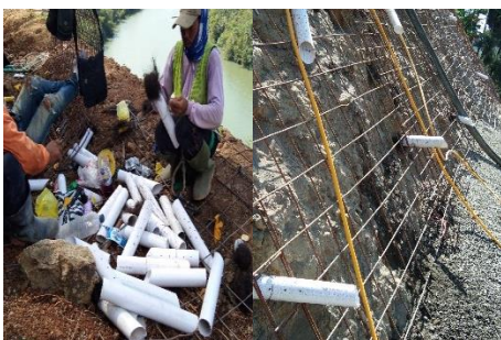
Gambar 12. Proses pemasangan pipa drainasi.
