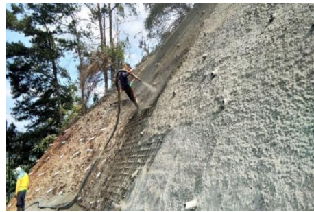
Gambar 13. Proses penyemprotan material shotcrete .
