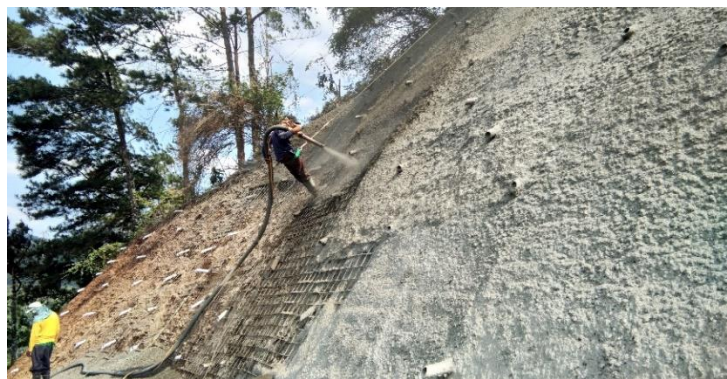
Gambar 4.13. Proses penyemprotan material shotcrete .
