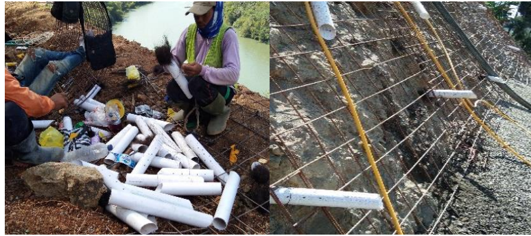
Gambar 4.12. Proses pemasangan pipa drainasi.
