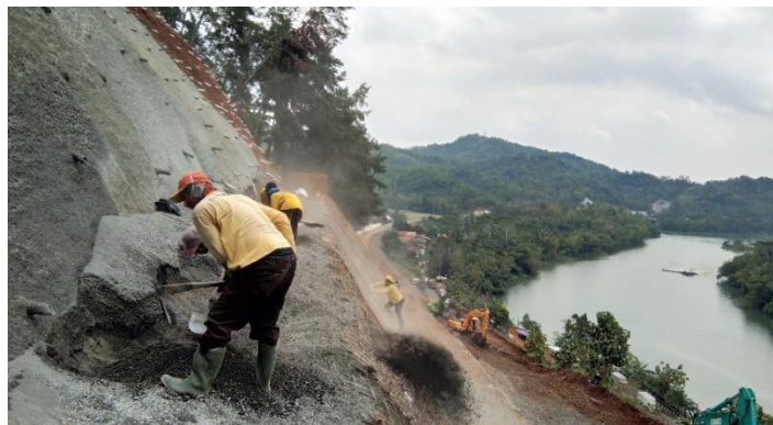
Gambar 4.14. Proses pembuangan sisa material shotcrete .
