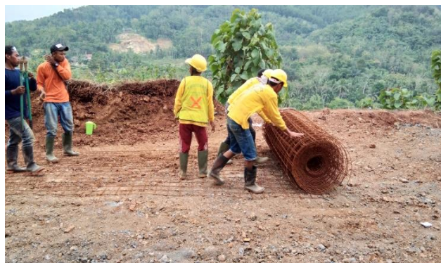
Gambar 4.9. Proses pemotongan besi wiremesh .
