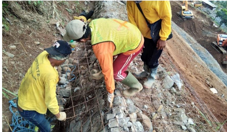
Gambar 4.10. Proses pemasangan besi wiremesh .
