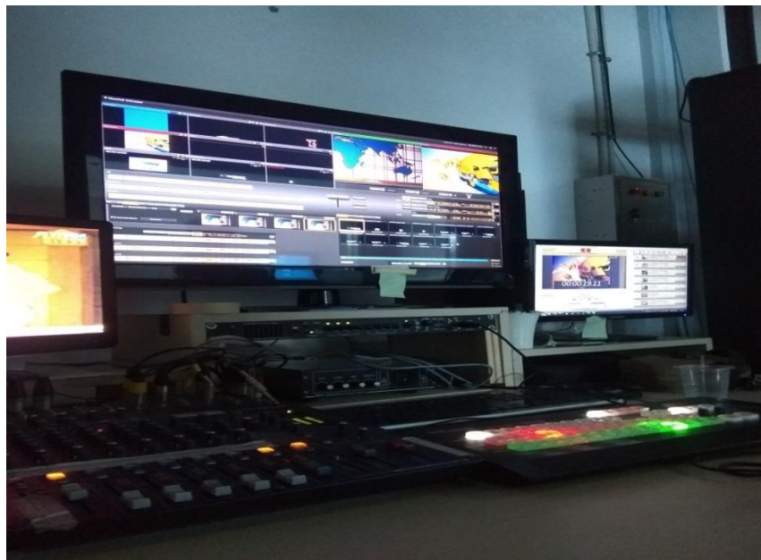
Master Control Room (MCR) untuk mengontrol proses pemberitaan Lensa
