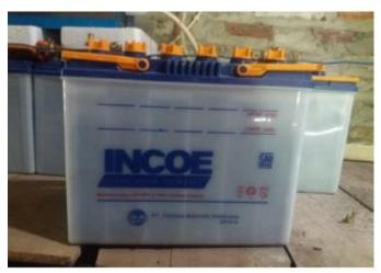
Gambar 4.2 Baterai yang digunakan pada PLTS
