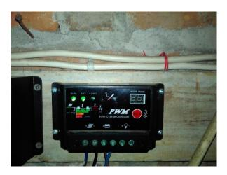
Gambar 4.3 Solar Charge Controller yang digunakan pada PLTS
