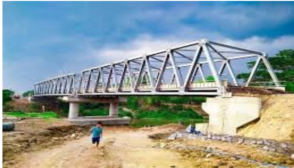
Gambar 1 Pembangunan Jembatan Rangka baja Kragan
