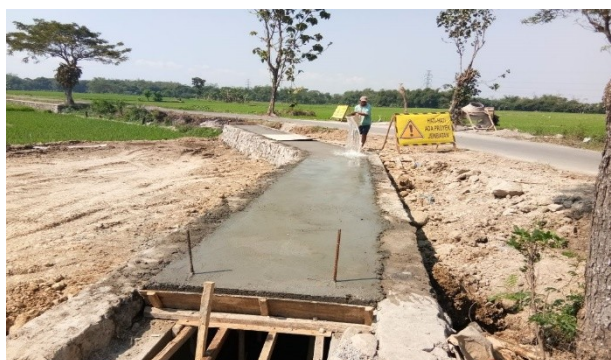
Gambar 1 Pekerjaan Saluran Air
