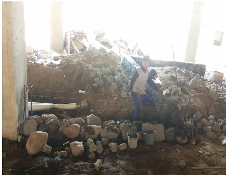
Gambar 4. 6 Proses Pemasangan Pondasi Batu Belah
