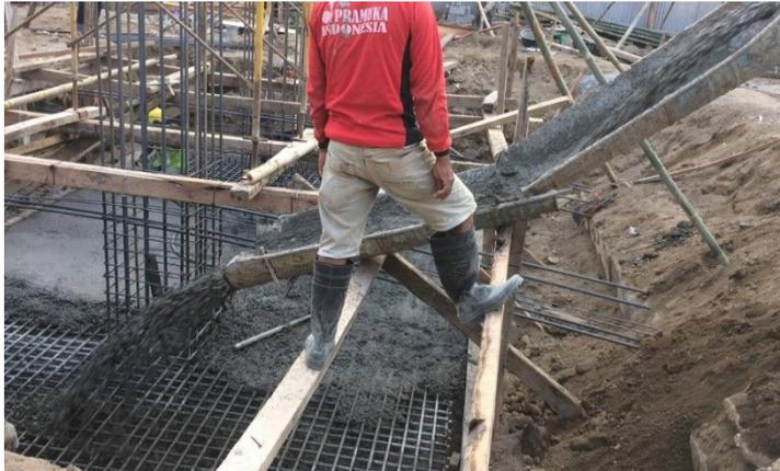
Gambar 4. 10 Pekerjaan Pengecoran Footplat
