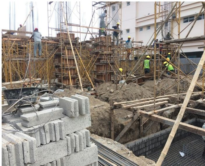
Gambar 4. 16 Pekerjaan Pengecoran Kolom Lantai Dasar
