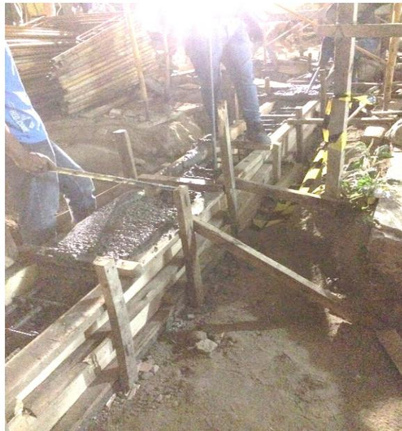
Gambar 4. 13 Pekerjaan Pengecoran Sloof
