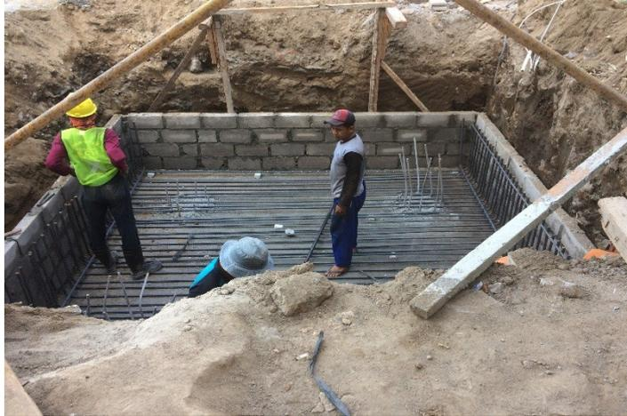
Gambar 4. 9 Pekerjaan Penulangan Footplat
