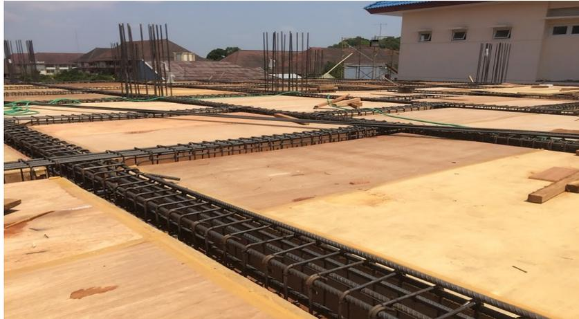
Gambar 4. 23 Proses Pemasangan Bekisting Plat Lantai dan Plat Kanopi
