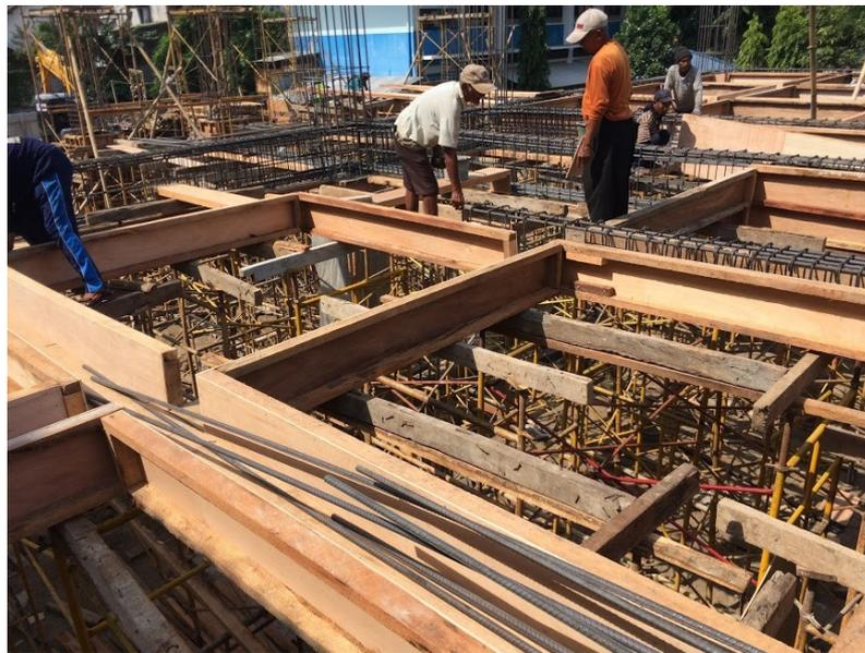
Gambar 4. 20 Proses Pemasangan Bekisting Balok Lantai
