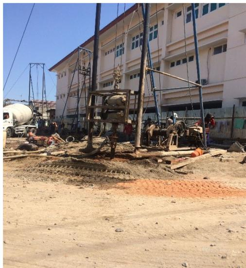
Gambar 4. 5 Proses Pekerjaan *Boor Pile*
