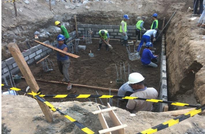
Gambar 4. 8 Pekerjaan Pemasangan Bekisting Footplat
