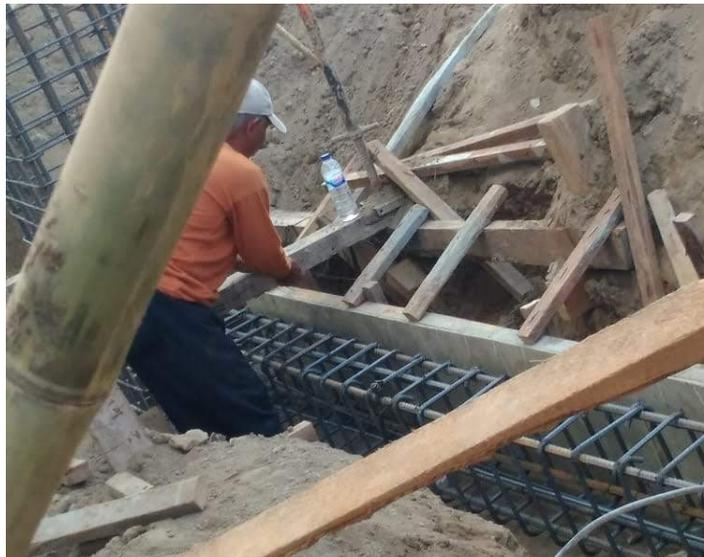
Gambar 4. 12 Pekerjaan Pemasangan Bekisting Sloof
