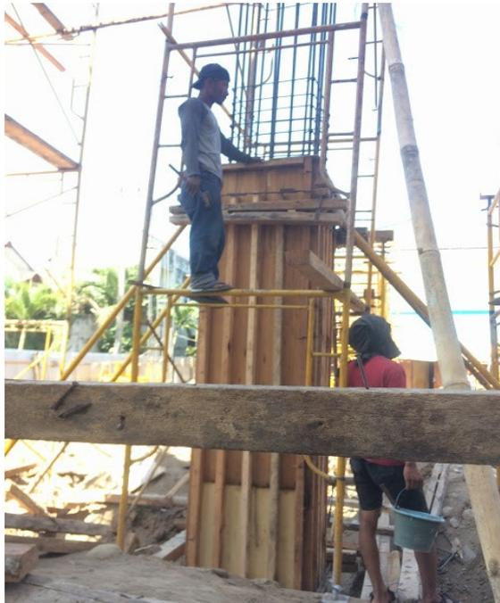
Gambar 4. 15 Pekerjaan Pemasangan Bekisting Sloof
