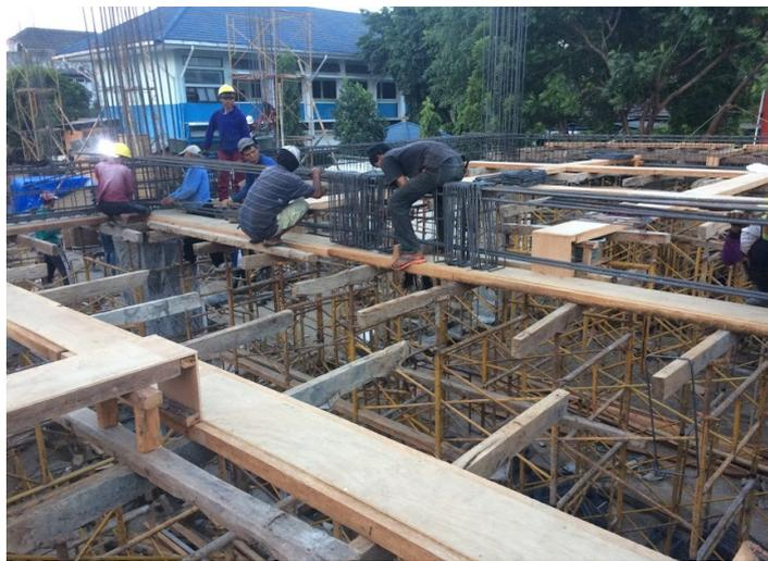
Gambar 4. 19 Proses Pekerjaan Penulangan Kolom dan Balok Lantai
