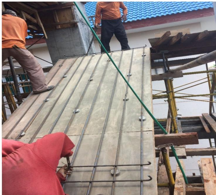
Gambar 4. 22 Proses Pekerjaan Balok Tangga dan Plat Tangga
