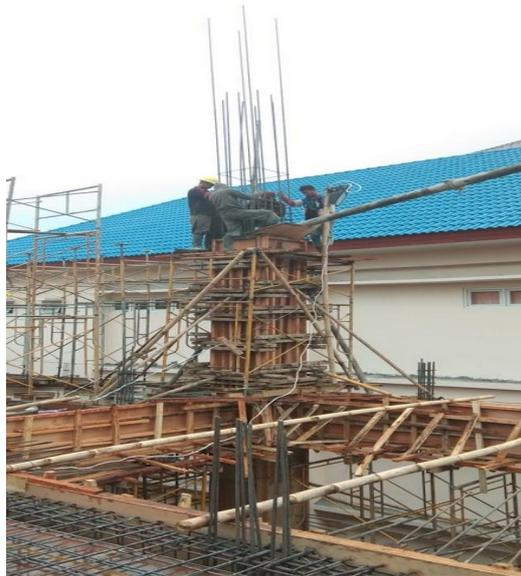
Gambar 4. 21 Proses Pengecoran Kolom
