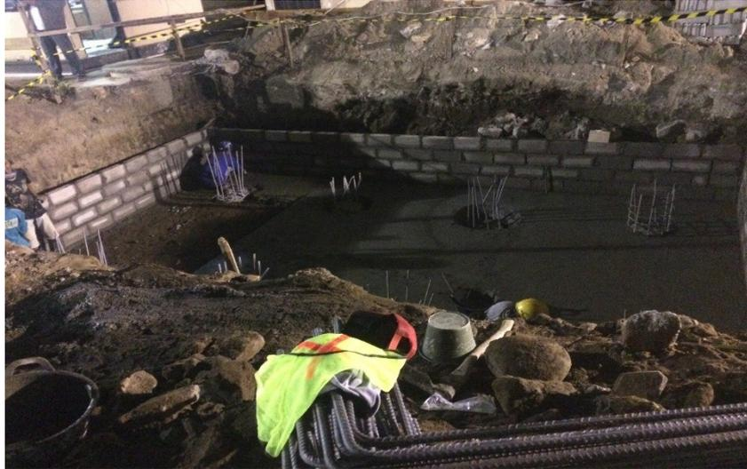
Gambar 4. 7 Proses Pembuatan Lantai kerja Bawah Footplat
