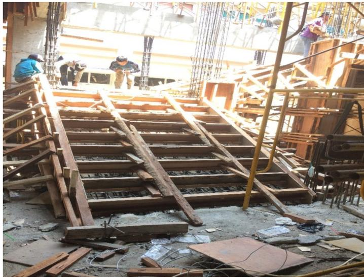
Gambar 4. 18 Pekerjaan Pemasangan Bekisting Balok Sabuk, Balok Tangga, dan Plat Tangga
