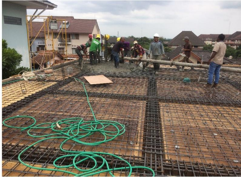
Gambar 4. 25 Proses Pengecoran Plat Lantai dan Plat Kanopi
