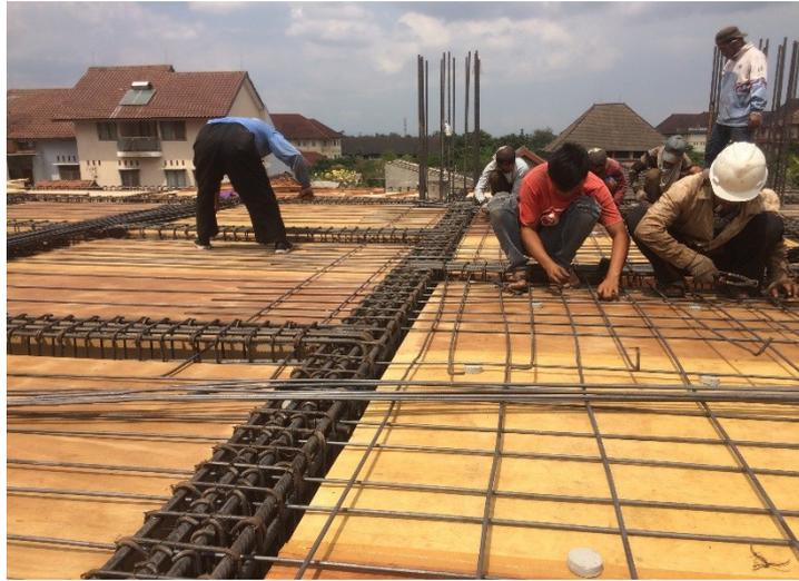
Gambar 4. 24 Proses Penulangan Plat Lantai dan Plat Kanopi
