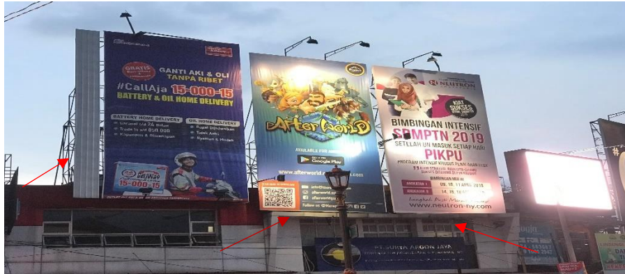
Gambar 4.49 Baliho yang didirikan di atas bangunan warga
