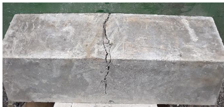
Gambar 3 Beton setelah dilakukan uji lentur (posisi benda uji terbalik)
