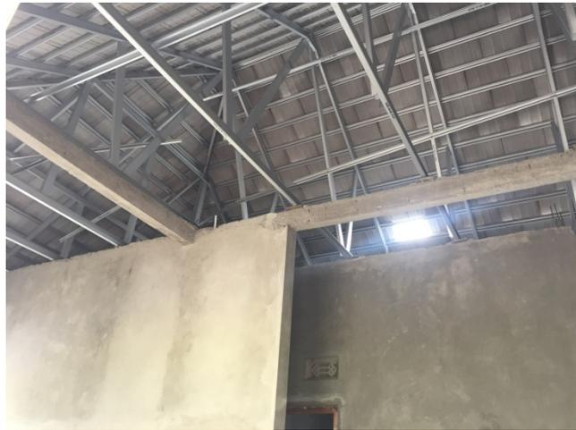
Foto 24 Bagian dalam bangunan dinding telah diplaster, bagian rangka atap menggunakan baja ringan,
