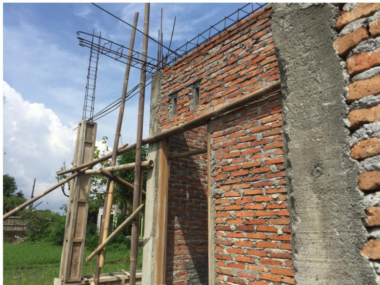
Foto 30 Sedang dilakukan pembesian untuk balok pada rumah kesepuluh dan berlanjut pada pemasangan rangka atap.
