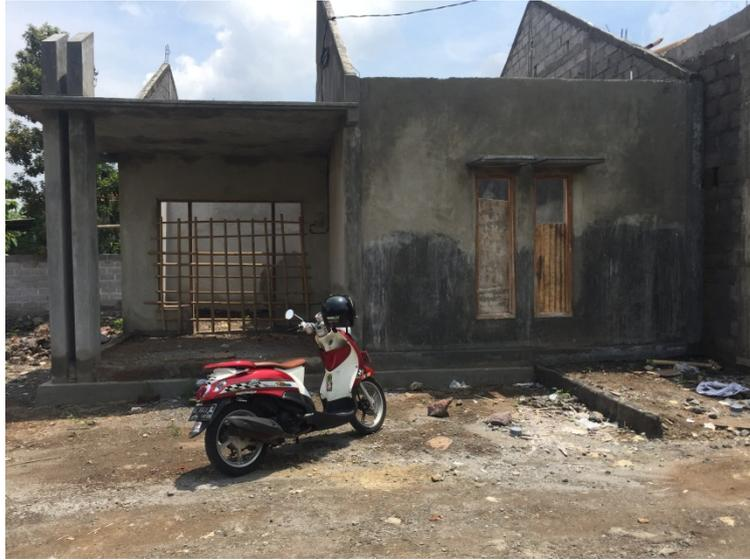
Foto 21 Tampak depan bangunan di lokasi keenam terdapat 2 kolom untuk teras
