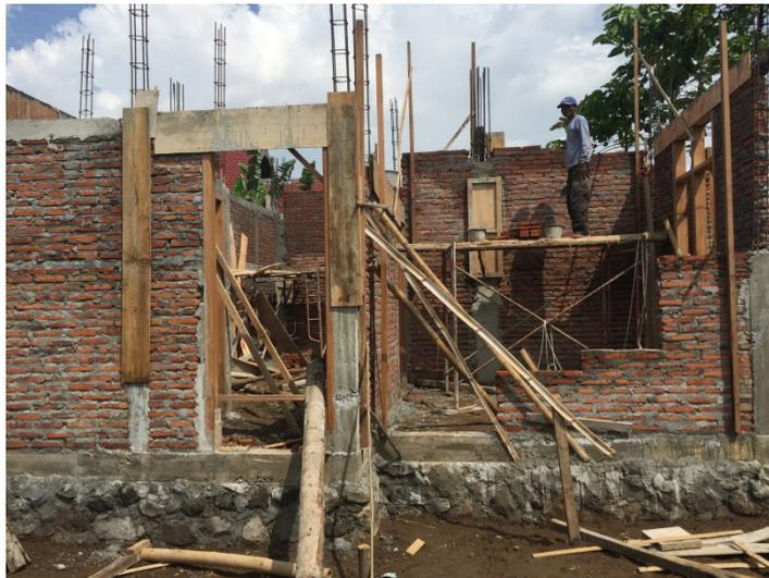
Foto 20 Pada bagian dalam terlihat pekerja sedang melakukan pemasangan batu bata untuk dinding rumah
