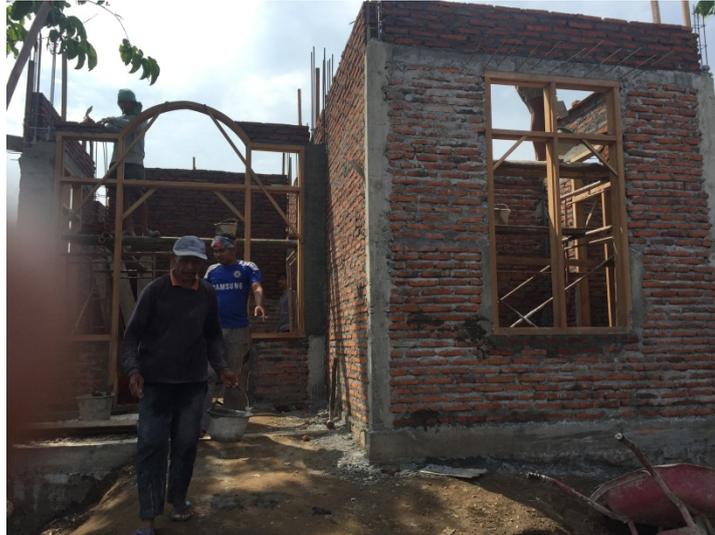
Foto 19 Pada bangunan rumah di lokasi kelima, pekerja atau tukang atau mandor sedang melakukan pekerjaan pemasangan kusen untuk jendela dan pintu rumah. Fungsi bangunan ini untuk tempat tinggal.
