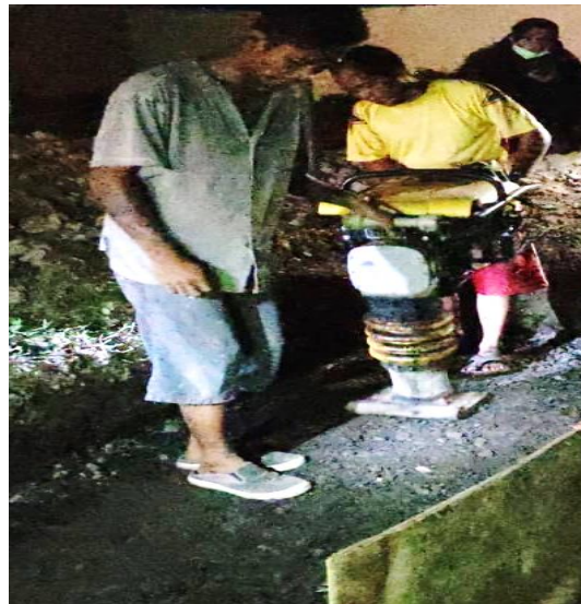
Gambar 3.17 Pemadatan material menggunakan mesin stamper
