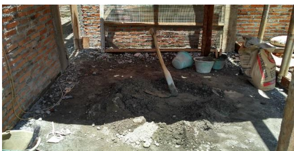
Gambar 16 Proses Pengadukan Campuran
