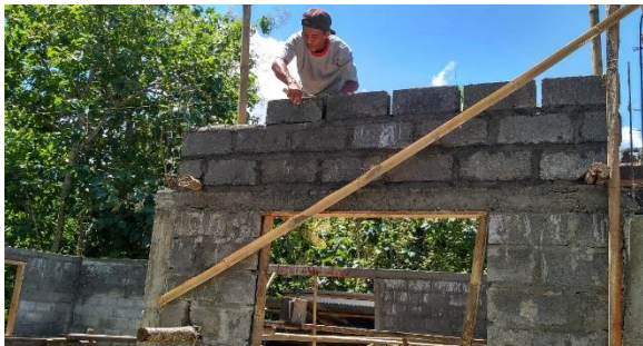
Gambar 15 Pemsangan Dinding
