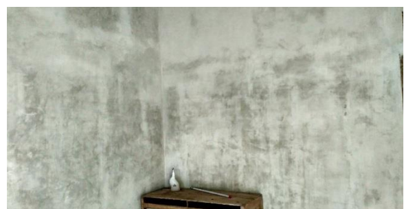
Gambar 19 Dinding yang telah diplester
