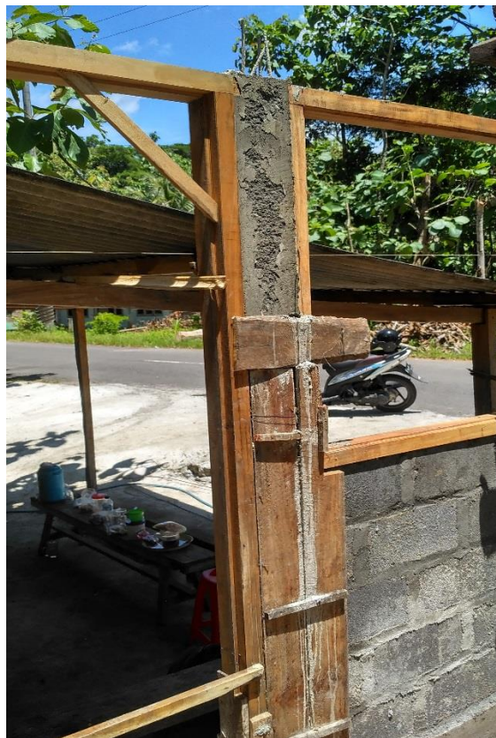
Foto 22 Tahap pengerjaan beton kolom, bekisting menggunakan kayu dan papan.
