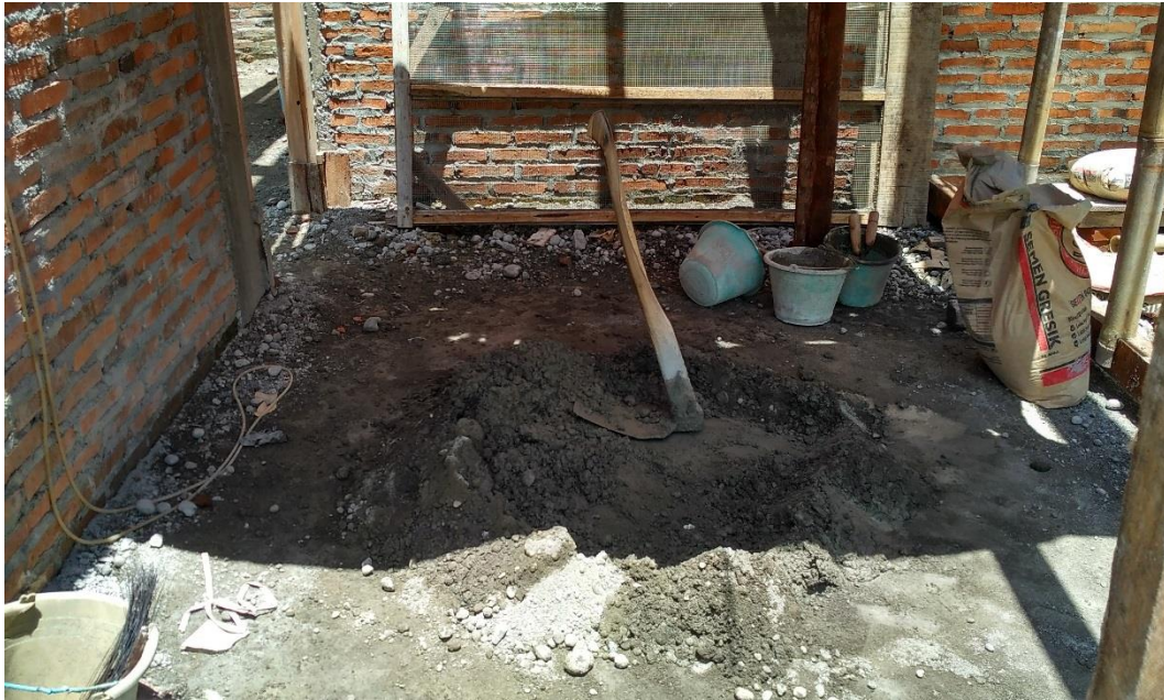
Foto 26 Campuran yang digunakan untuk pembuatan beton (balok dan kolom), dalam campuran menggunakan perbandingan 1 Semen : 2 Pasir : 3 Kerikil.
