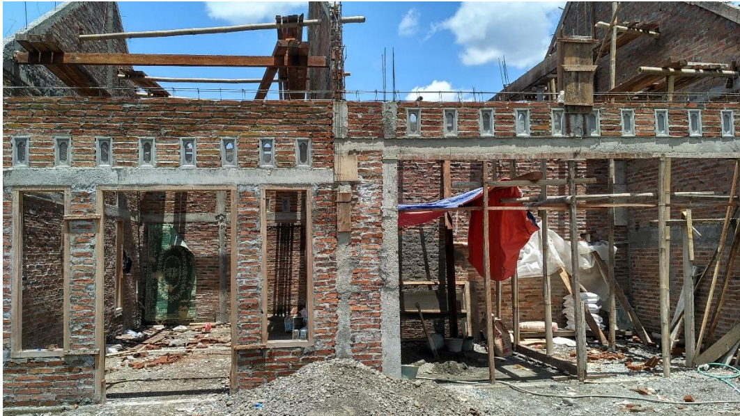
Foto 24 Tampak depan bangunan kedelapan tahap pembangunan beton (kolom dan balok), bekisting yang digunakan papan dan kayu yang ada ditempat, bagian dinding menggunakan batu bata yang belum diplester, rangka atap belum terpasang, fungsi bangunan adalah sebagai tempat tinggal.
