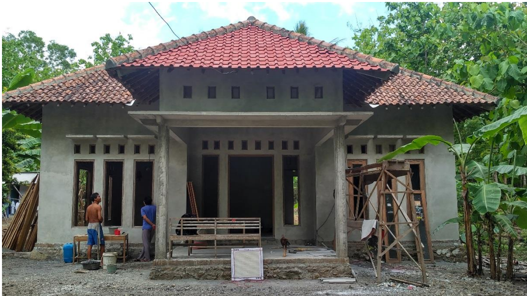
Foto 15 Tampak depan bangunan rumah keempat terdapat 2 kolom didepan untuk teras, terlihat bagian dinding depan bangunan sudah dipleser.
