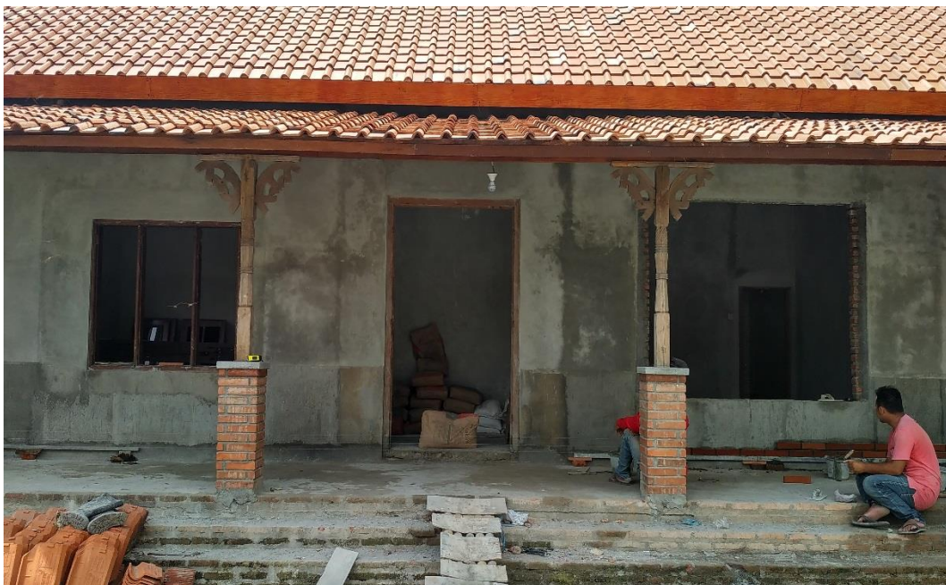
Foto 27 Tampak depan lokasi pembangunan rumah ke sembilan, terdapat 2 penyangga dari kayu untuk menahan atap teras, bagian dinding depan sudah diplester, terlihat juga bahan pembangunan seperti semen dan genteng.
