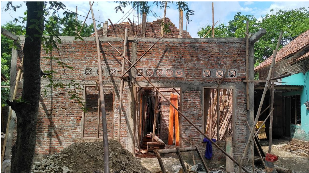
Foto 19 Tampak depan bangunan rumah keenam, rangka atap bagunan belum terpasang dan dinding bagunan menggunakan batu bata yang belum dipleser.
