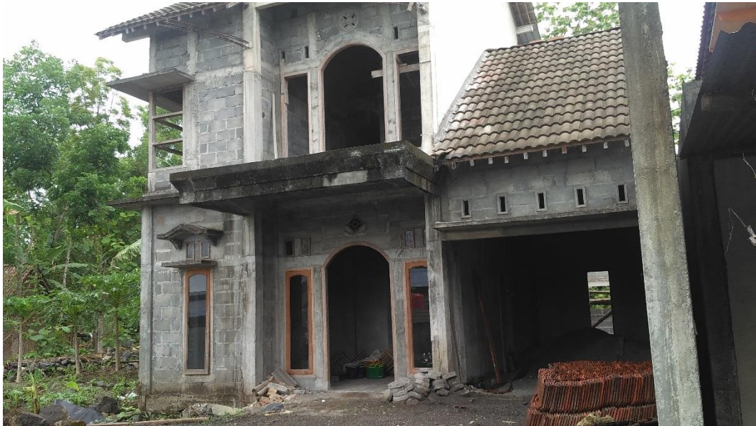
Foto 10 Tampak depan bangunan rumah pertama, bangunan tersebut sudah hampir selesai dan masih terlihat bahan material seperti pasir, genteng, dan batako.
