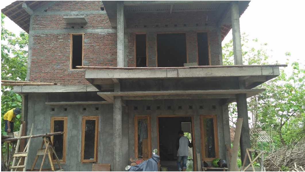
Foto 14 Tampak depan lokasi bangunan ketiga terdapat 2 kolom untuk teras, ubin juga sudah terpasang pada lantai 1. Bangunan tersebut menggunakan batu bata terlihat juga pekerja sedang melakukan plesteran pada dinding bangunan.
