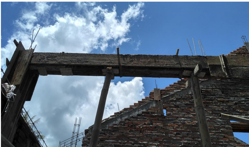
Foto 25 Tahap pengerjaan beton (balok dan kolom) bekisting menggunakan kayu dan papan, bangunan dalam tahap pengerjaan rangka atap.
