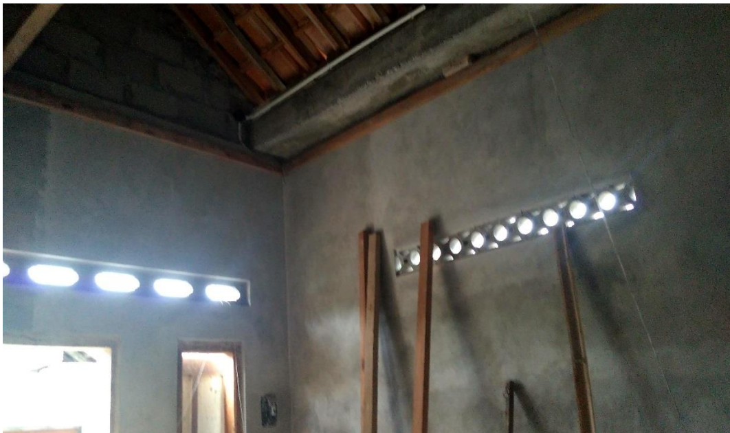
Foto 13 Bagian rangka atap bangunan menggunakan kayu dan terlihat balok sebagai penyangga, fungsi bangunan untuk tempat tinggal
