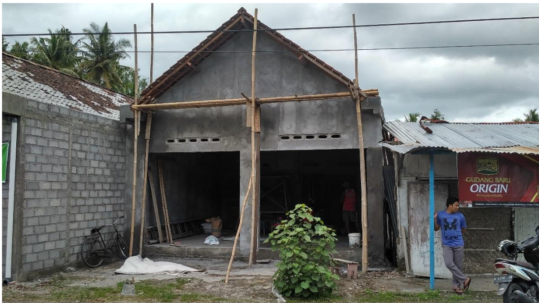
Foto 11 Tampak depan bangunan rumah kedua, para pekerja didalam bangunan rumah tersebut sedang melakukan plester untuk dinding.
