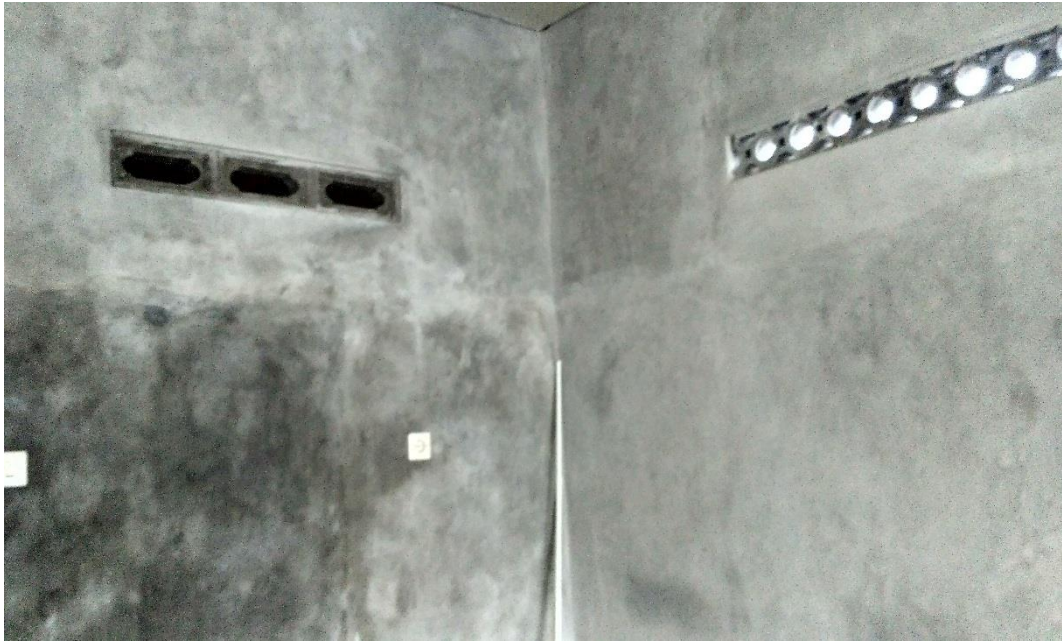
Foto 12 Tampak bagian dalam bangunan dinding telah selesai dipleseter
