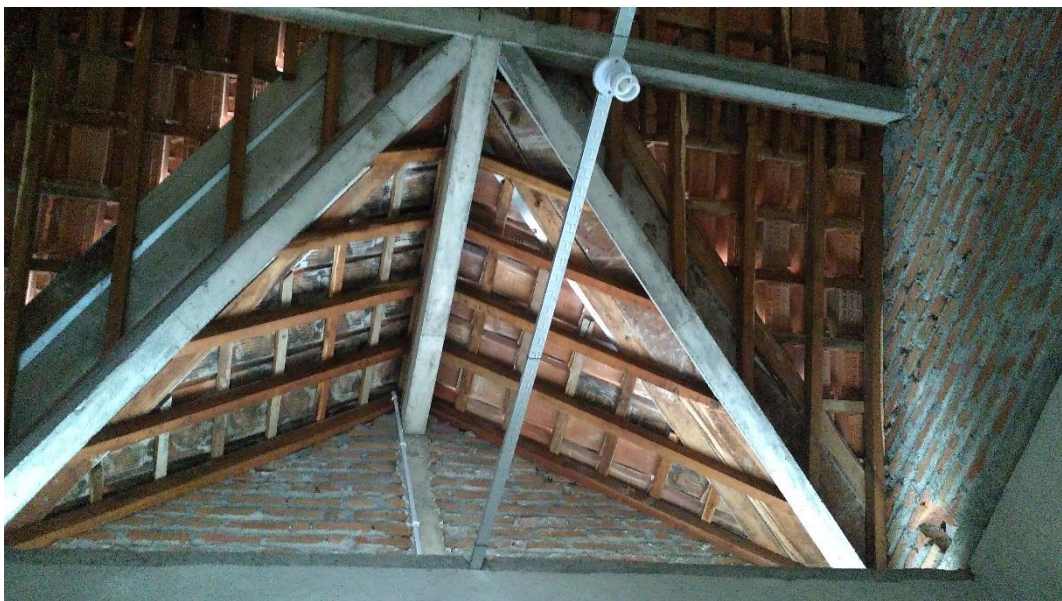
Foto 17 bagian rangka atap bangunan menggunakan kayu dan kuda-kuda menggunakan cor beton, bangunan tersebut difungsikan untuk tempat tinggal.
