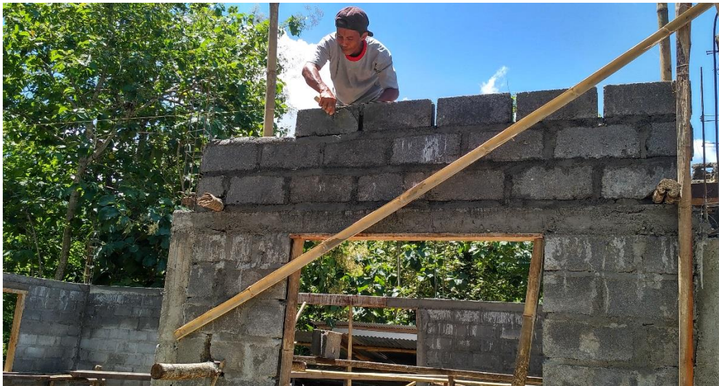
Gambar 4.13 Pemasangan dinding
