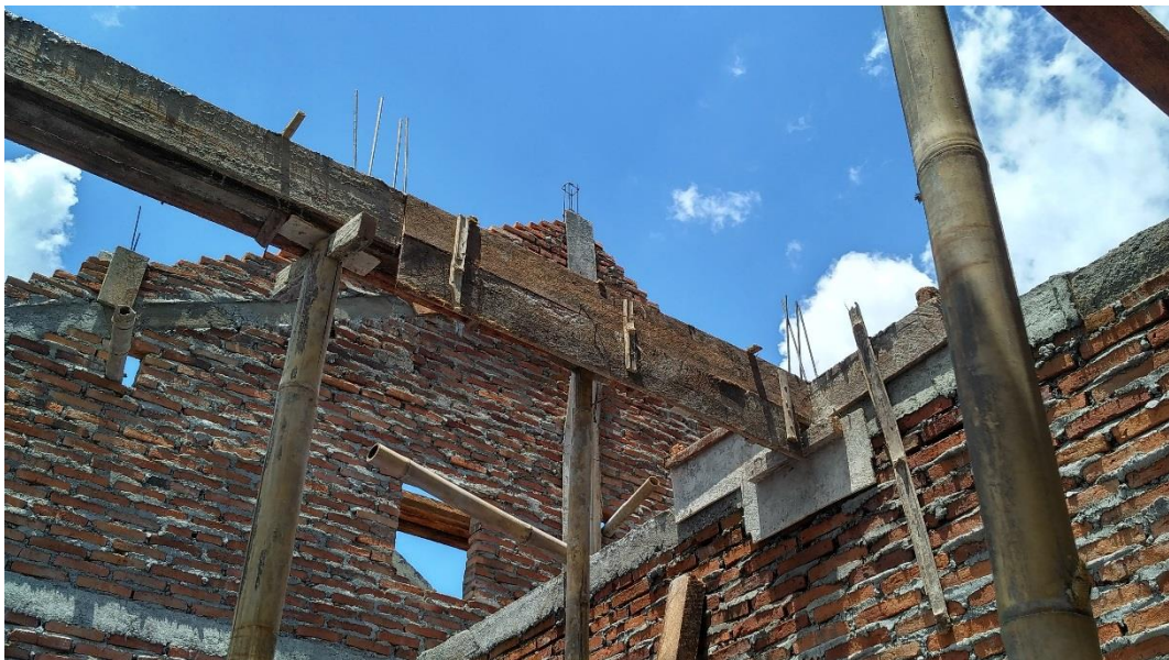
Gambar 4.15 Pembuatan balok bangunan rumah
