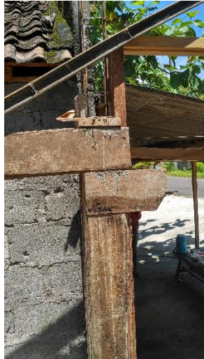
Gambar 4.16 Pembuatan kolom praktis pada bangunan rumah
