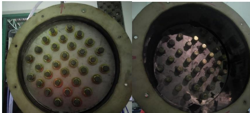
Gambar 3. 10. Dudukan penopang pipa tembaga.
