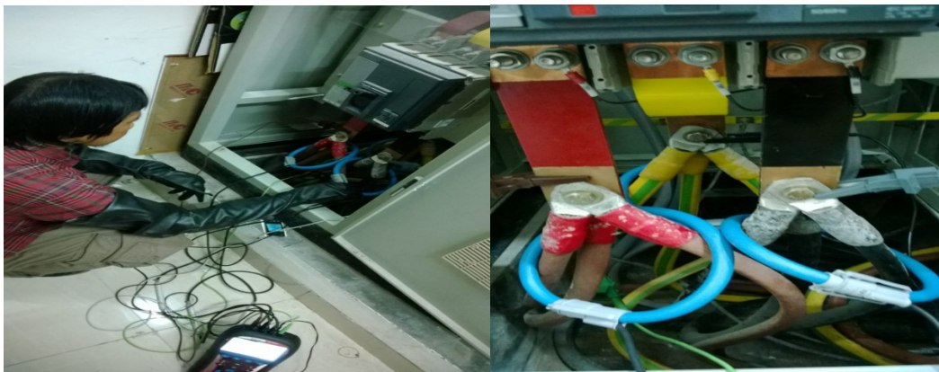
Gambar 3.7 Pengambilan Data di Panel SDP
