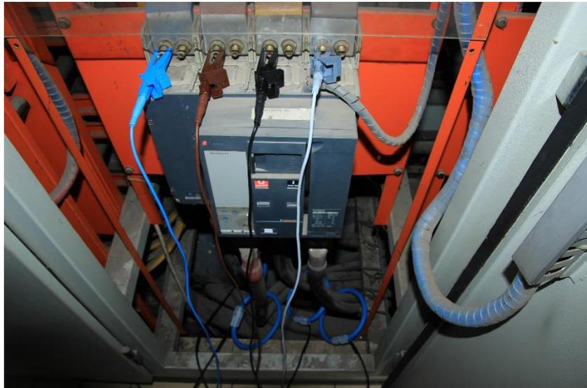
Gambar 3. 2 Pemasangan Kabel Jumper pada MDP
