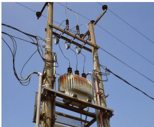
Gambar 2.13 Gardu induk tegangan menengah PLN (Sumber : http://seputarbanjarpatroman.blogspot.com )
