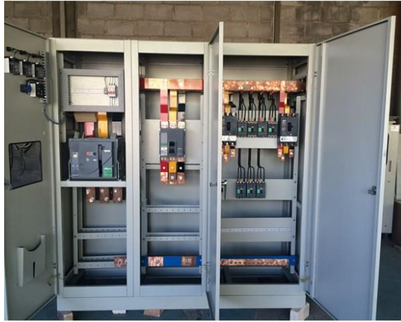
Gambar 2.16 panel utama tegangan rendah (Sumber: https://www.google.com )
