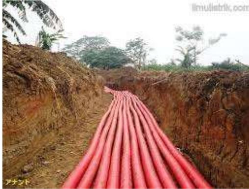
**Gambar 2.4** Saluran Kabel Tegangan Menengah
