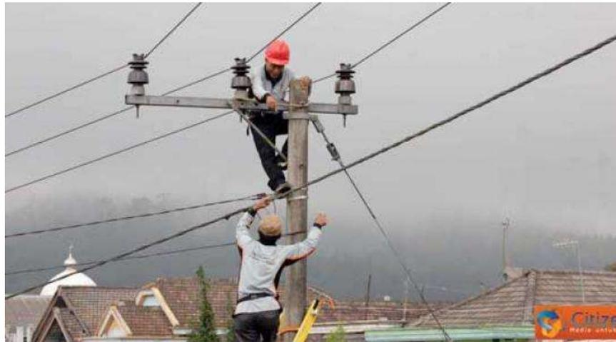
**Gambar 2.3** Saluran Kabel Udara Tegangan Menengah
