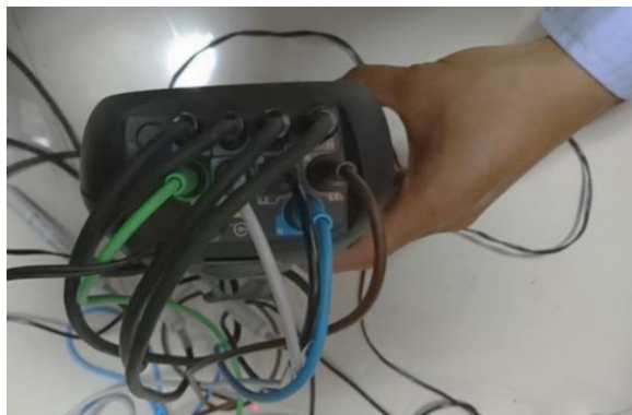
Gambar 3.5 Pemasangan Kabel Probe pada METREL
