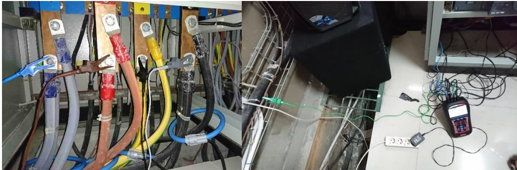
Gambar 3.9 Pemasangan Clamp Tegangan, Arus dan Ground
