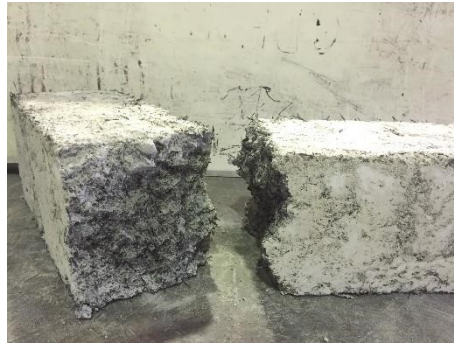
Gambar 4. 5 Beton yang mengalami porous/keropos setelah pengujian
