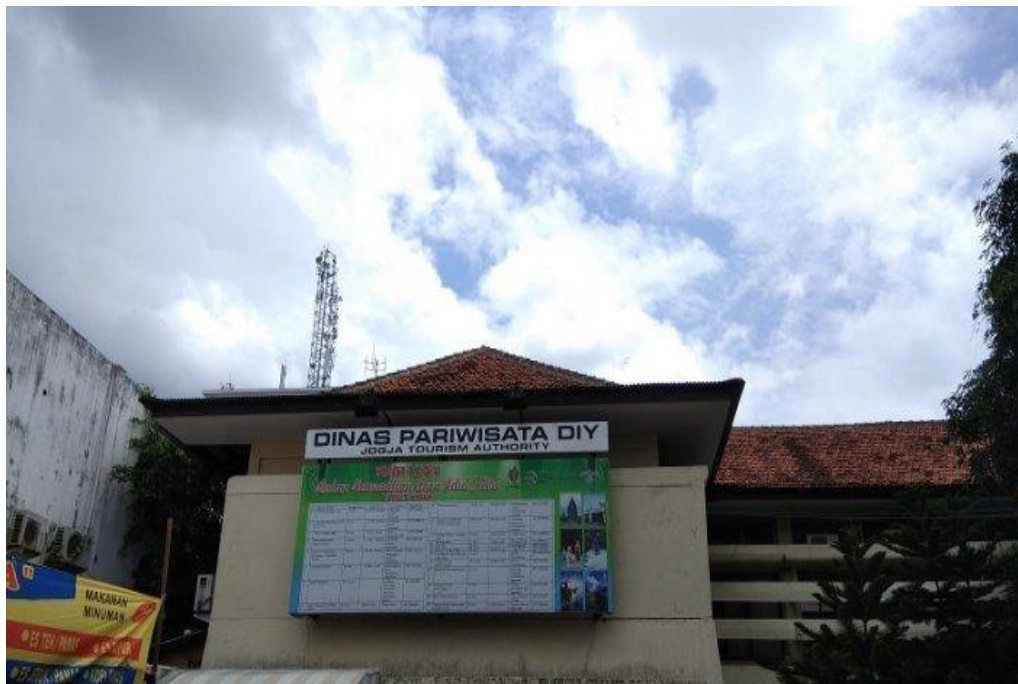
Lampiran 2. Lokasi penelitian Gedung Kantor Dinas Pariwisata
