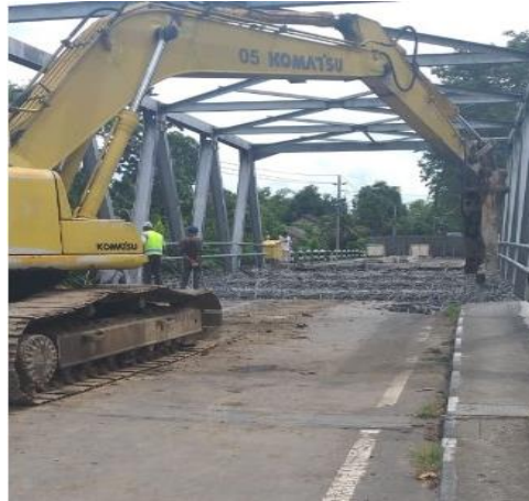
Gambar 4.7 Pembongkaran beton
