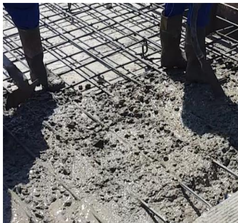
Gambar 4.4 Pengecoran lantai jembatan
