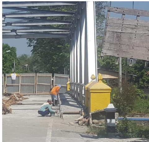
Gambar 4.9 Pemasangan kerb pracetak jenis 1 (peninggi/ mountable )
