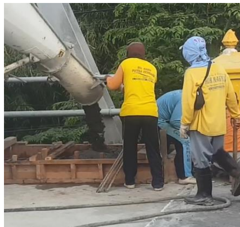
Gambar 4.6 Pengecoran trotoar
