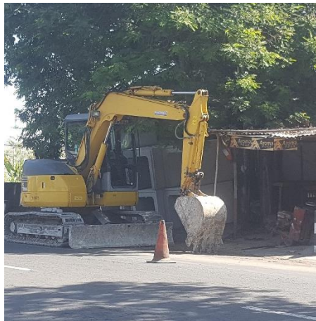
Gambar 4.1 Ilustrasi Pengerjaan galian perkerasan beraspal
