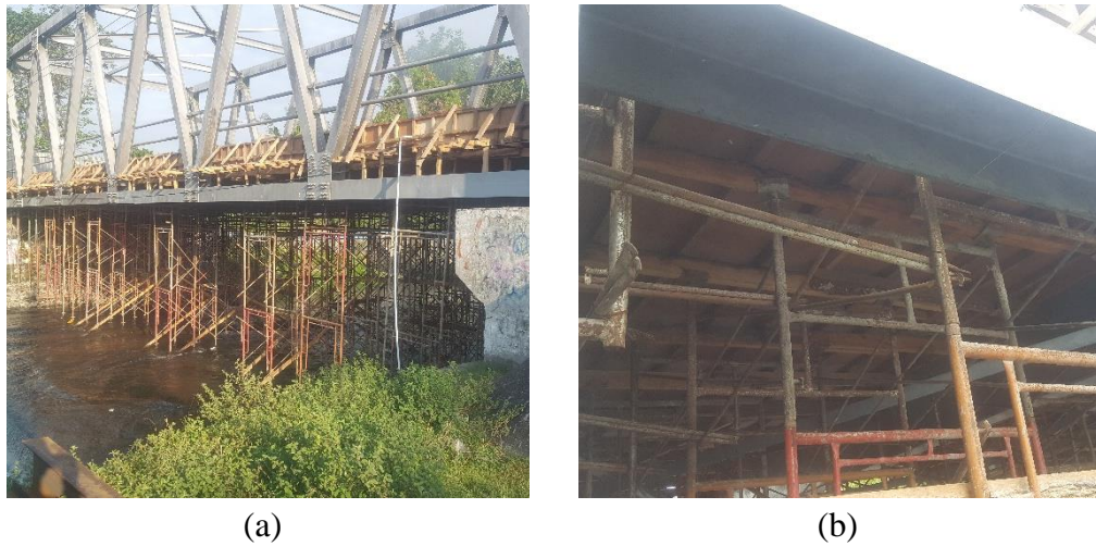
Gambar 4.5 Letak scaffolding sebagai penahan bekisting bawah
