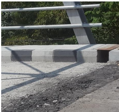
Gambar 9 Kerb pada trotoar
