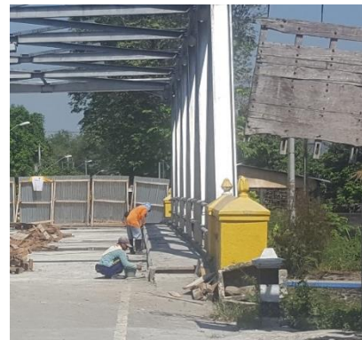
Gambar 7 Pemasangan kerb pracetak jenis 1
