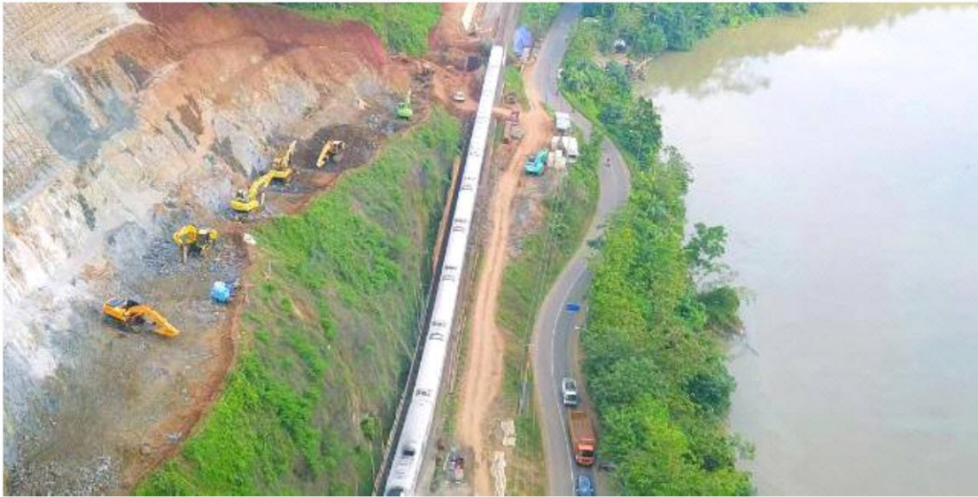
Proses Penggalian Tanah Kondisi Normal
