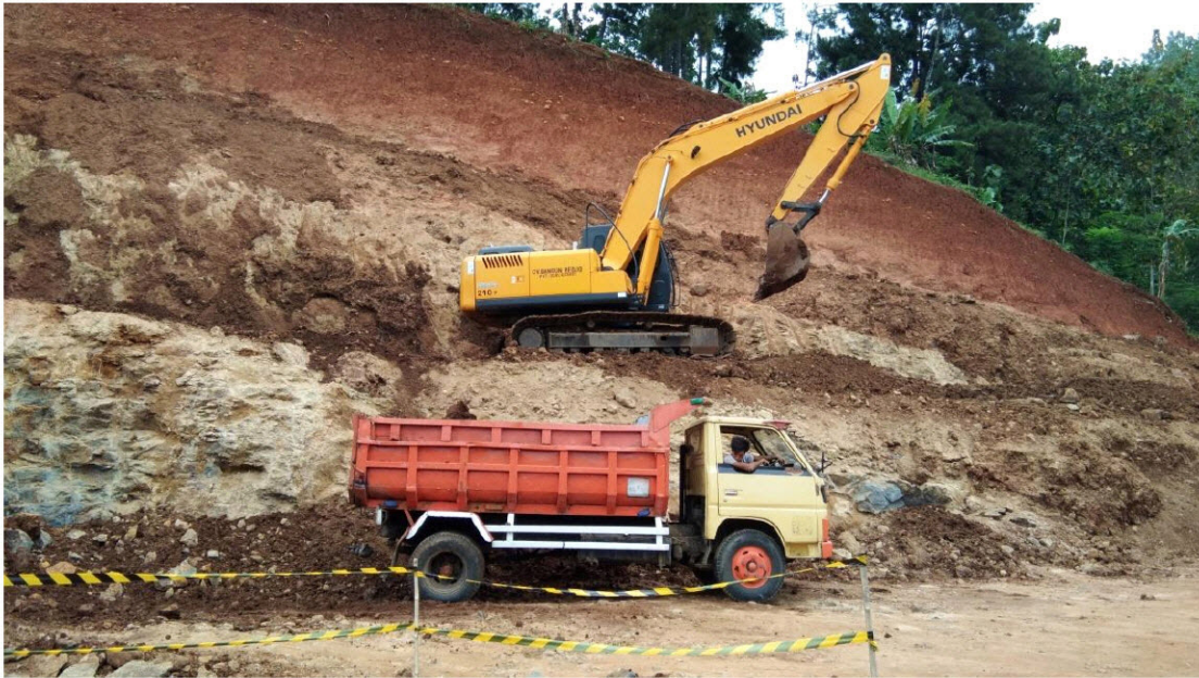
Gambar Proses Loading Pembuangan Tanah Galian
