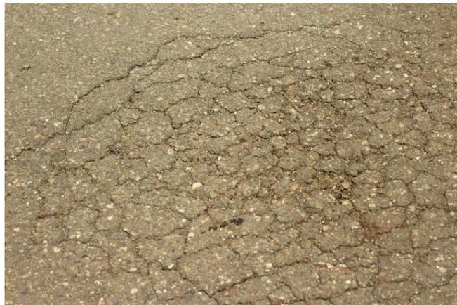
Gambar 2.5 Retak Kulit Buaya (*Aligator Cracking*)
