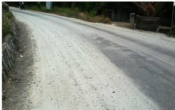
Gambar 2.41 Pelepasan Butir (*Weathering/Raveling*)
