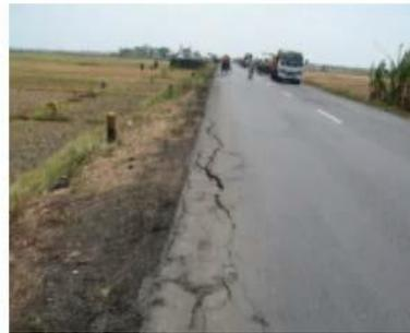
Gambar 2.17 Retak Samping Jalan (*Edge Cracking*)
