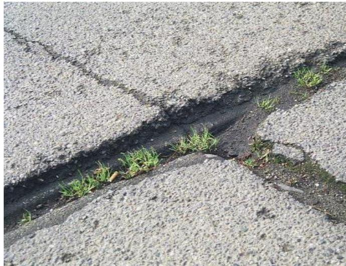
Gambar 2.19 Retak Sambung (*Joint Reflec Cracking*)
