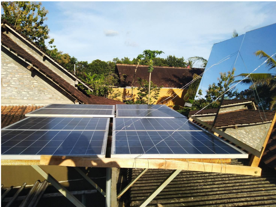
Gambar 2. Panel Surya Dengan Reflektor Kaca
