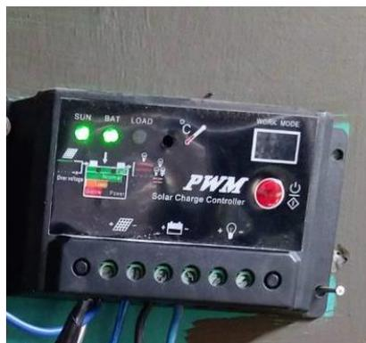
Gambar 4.3 Solar Charge Controller yang ada pada PLTS batik Sri Sulastri
