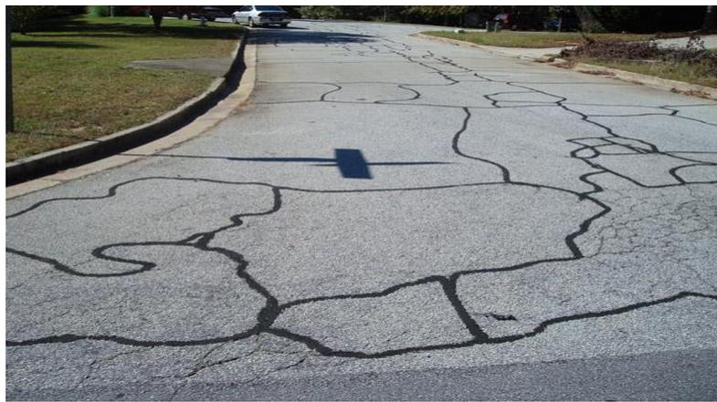
Gambar 2. 7 Retak kotak-kotak
