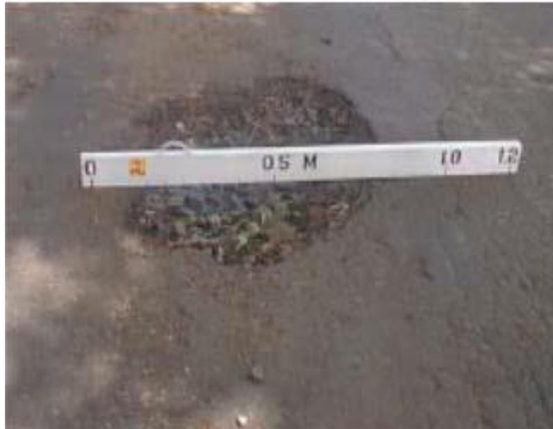
Gambar 2. 27 *Pothole* (lubang)
