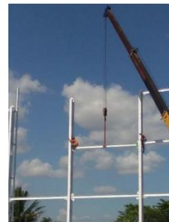
Gambar 5 Pekerjaan Balok Baja
