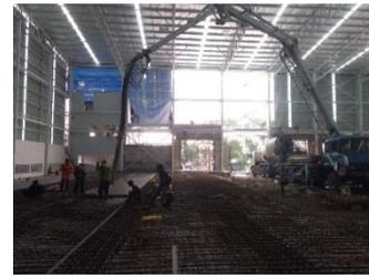
Gambar 3 Pengecoran Plat Lantai
