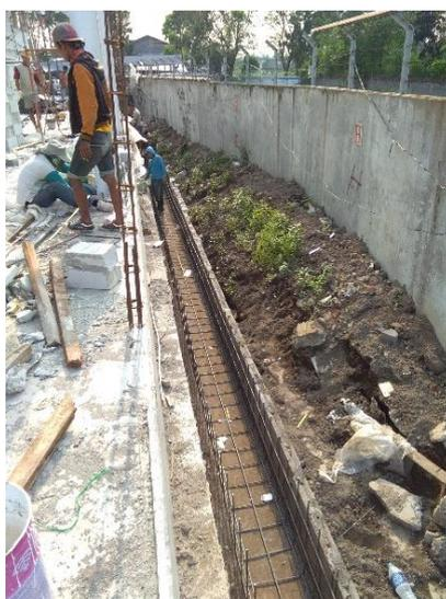
Gambar 4. 3 Pekerjaan Pembedon Drainase
