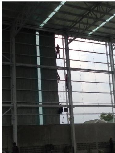
Gambar 4. 21 Pekerjaan Pemasangan Dinding Seng
