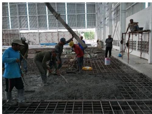
Gambar 4. 15 Proses Penuangan Beton Cor
