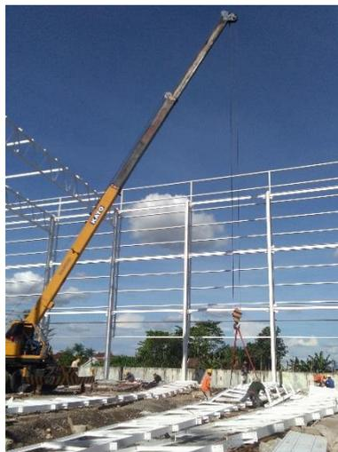
Gambar 4. 24 Perakitan Rangka Kuda-Kuda Atap
