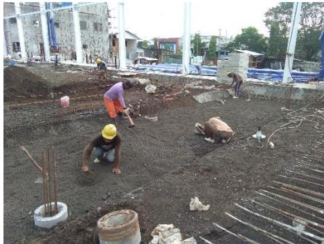
Gambar 4. 10 Pekerjaan Timbunan dan Perataan dengan Pasir
