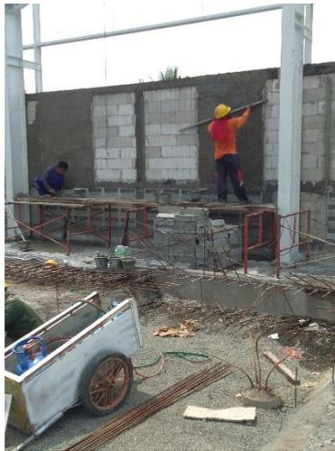
Gambar 4. 22 Pekerjaan Pemlesteran Dinding Bata Ringan
