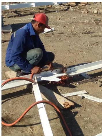
Gambar 4. 25 Pengelasan Rangka Kuda-Kuda Atap
