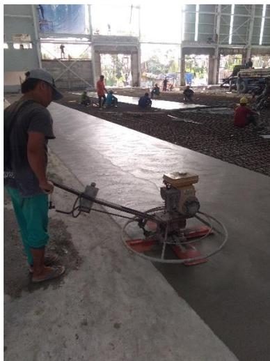
Gambar 4. 16 Proses Meratakan Lantai dengan Mesin Trowel
