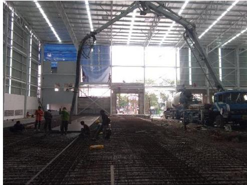
Gambar 4. 14 Pekerjaan Pengecoran Plat Lantai
