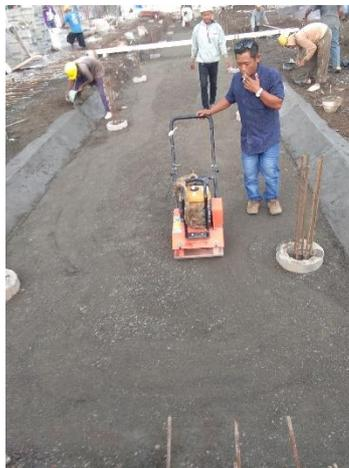
Gambar 4. 11 Pekerjaan Pemadatan Pasir
