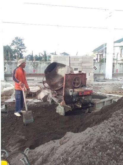
Gambar 4. 4 Proses Pengadukan Beton dengan Mesin Molen Kecil
