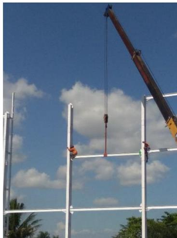
Gambar 4. 18 Pekerjaan Pemasangan Balok Baja
