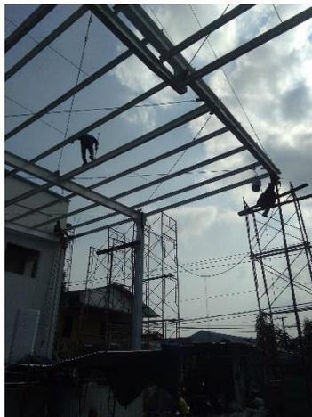
Gambar 4. 33 Pemasangan Baja Kanopi
