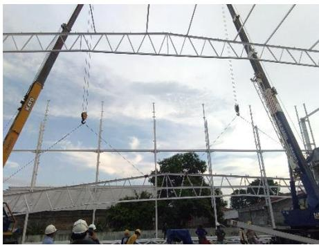
Gambar 4. 27 Pengangkatan Rangka Atap untuk Dipasang
