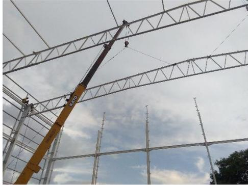
Gambar 4. 28 Pemasangan Rangka Kuda-Kuda Atap
