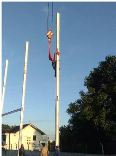
Gambar 4. 17 Pekerjaan Pemasangan Kolom Baja
