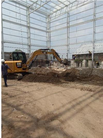
Gambar 4. 7 Proses Penggalian Tanah untuk Plat Lantai
