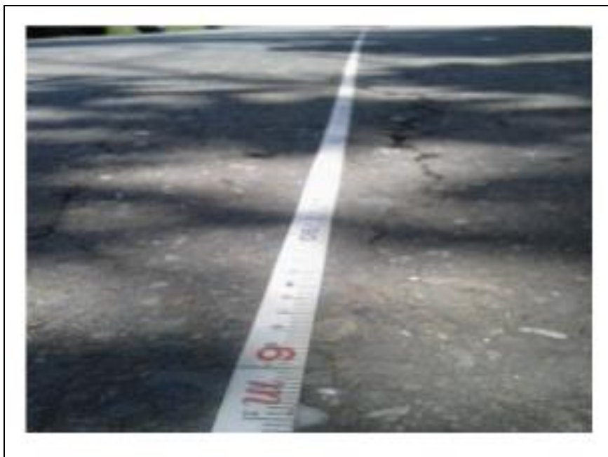
Gambar 2.25 Pengausan Agregat
