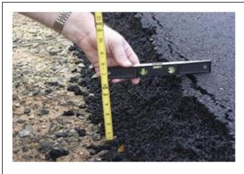
Gambar 2.19 Pinggir jalan turun vertikal
