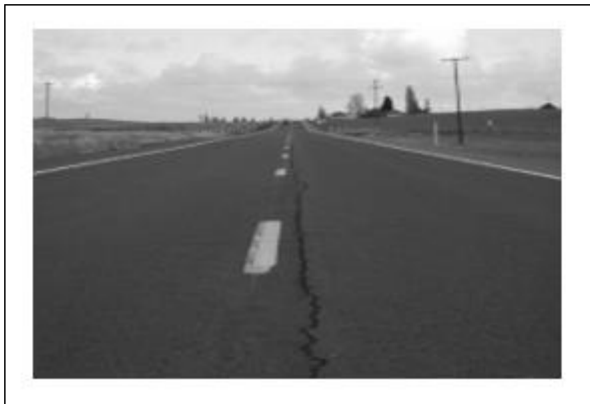
Gambar 2.21 Retak Memanjang/Melintang
