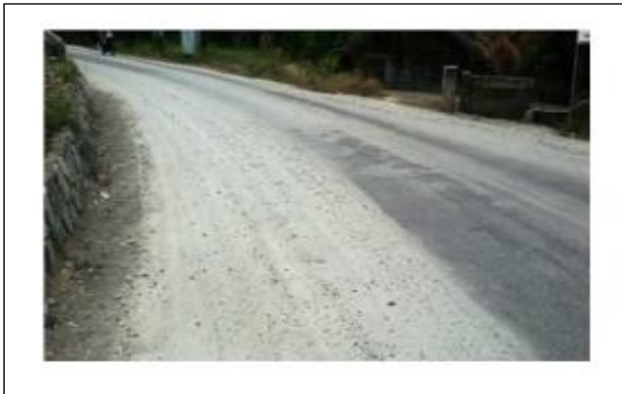
Gambar 2.39 Pelepasan butiran (Wathering/Raveling)
