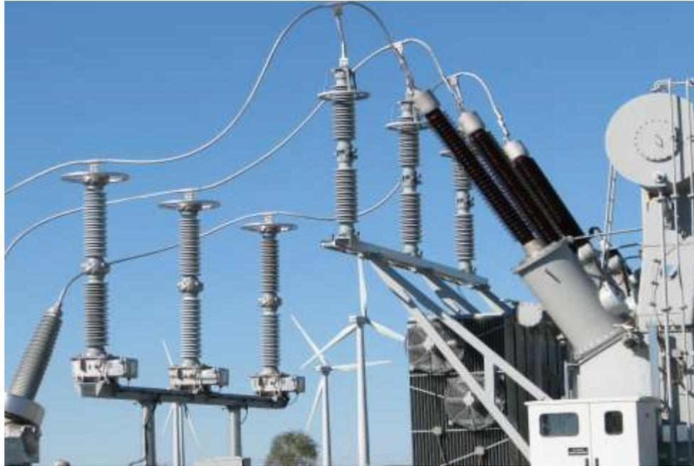
Gambar 2. 9 Bentuk Fisik Lightning Arrester
