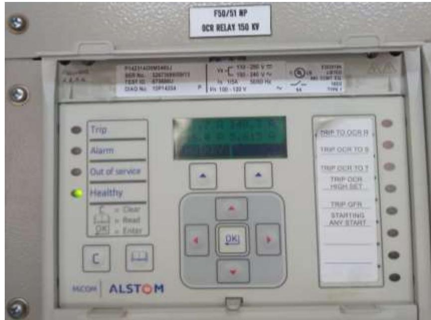
Gambar 2. 10 Contoh bentuk fisik relay proteksi (OCR)
