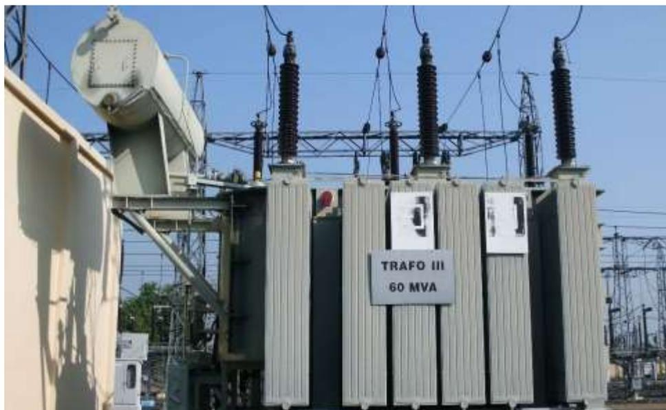
Gambar 2. 3 Bentuk Fisik Transformator Daya
