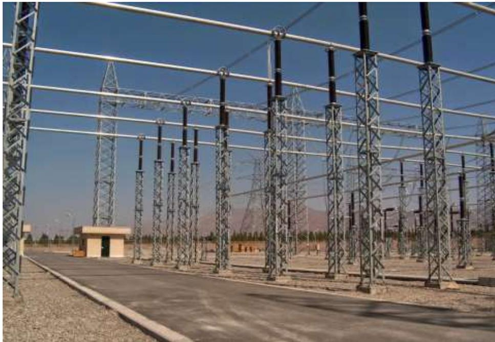
Gambar 2. 12 Bentuk Fisik Rel Busbar
