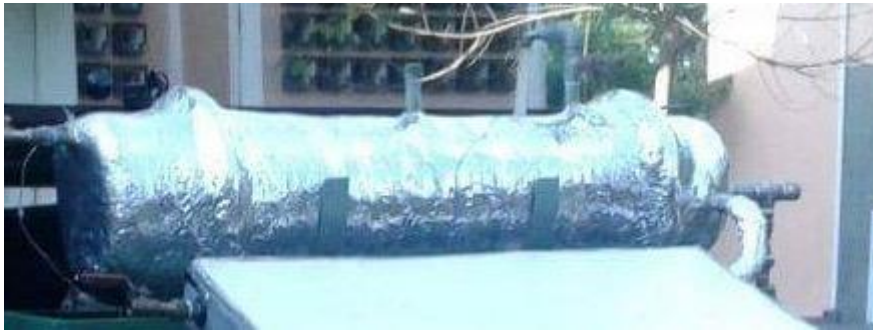
Gambar 4.16. Perancangan Glaswool Pada Tangki Dilapisi Alumunium Foil.
