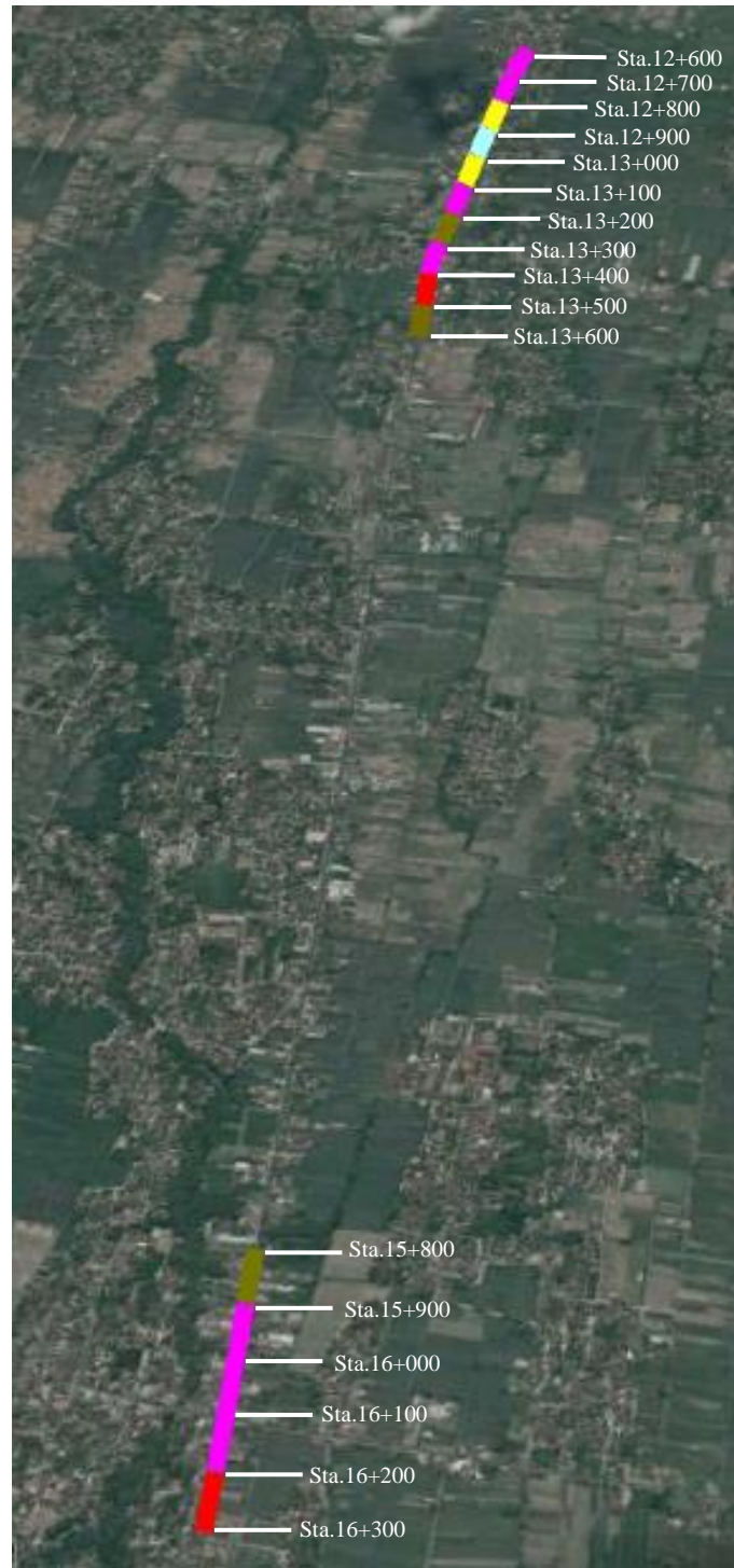
Gambar 4.12. Kondisi kerusakan jalan (Google Earth, 2019).
