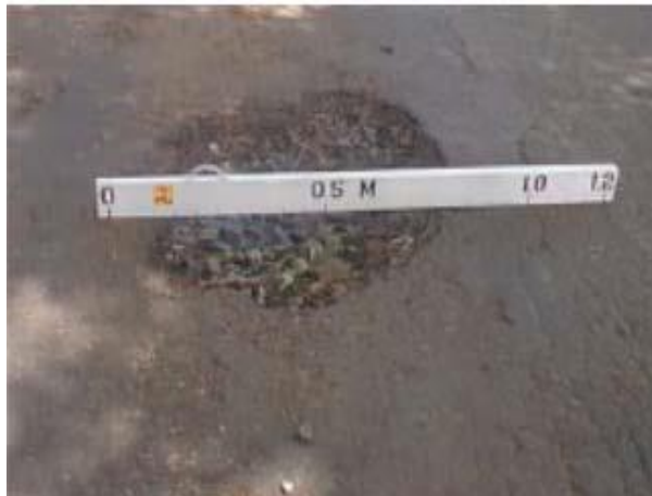
Gambar 2.25. Kerusakan lubang (Bina Marga, 1983).
