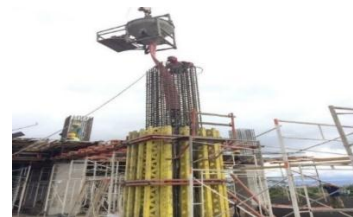
Gambar 8 Pekerjaan pengecoran kolom
