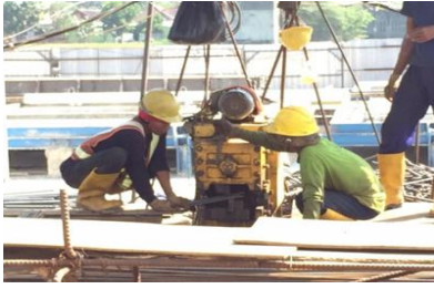
Gambar 4 Pematangan tulangan dengan Bar Cutter
