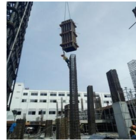
Gambar 7 Pekerjaan pemasangan bekisting kolom
