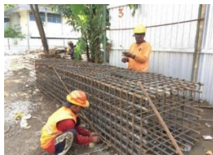
Gambar 6 Pekerjaan rangkaian tulangan kolom
