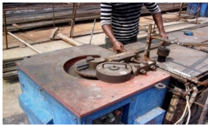
Gambar 5 Pekerjaan pembengkokan tulangan dengan Bar bender
